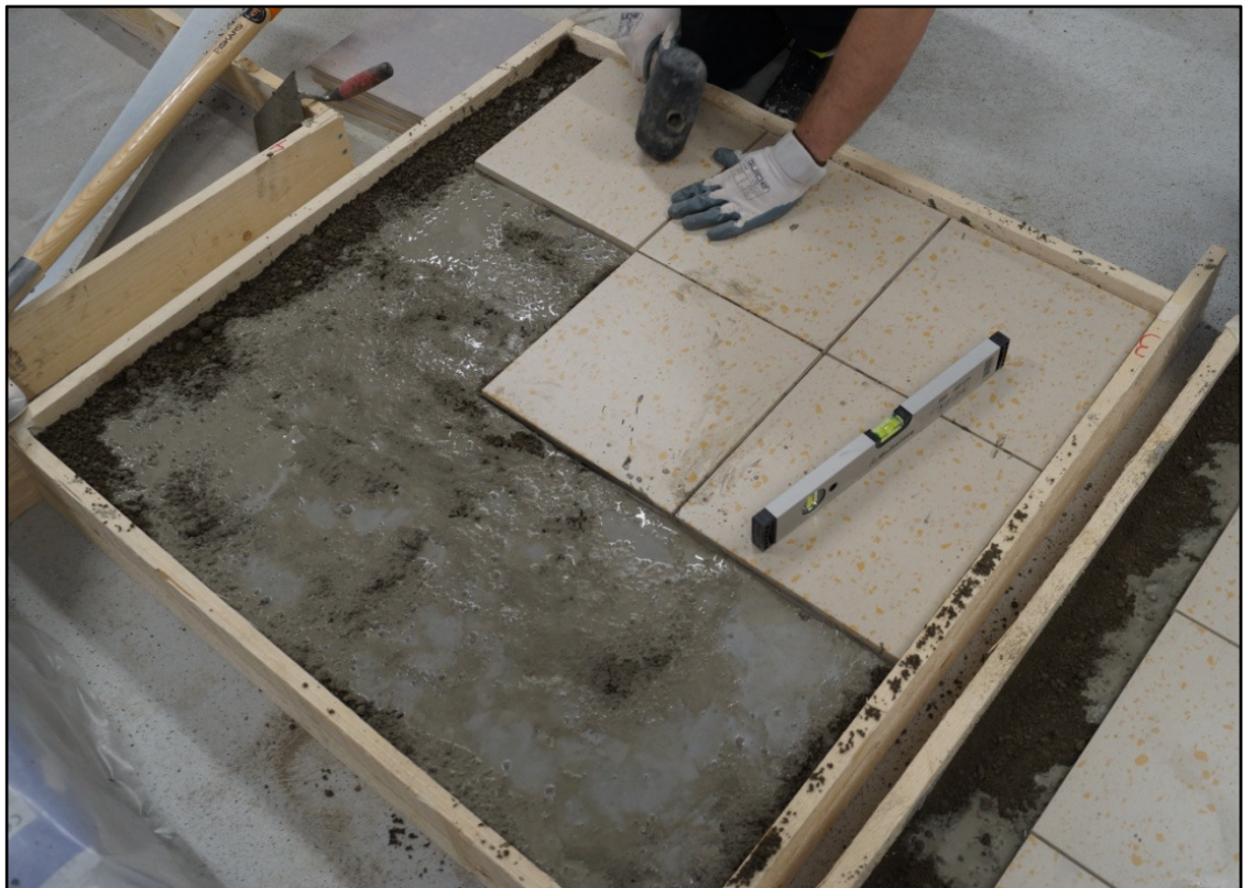
Kuva 11 Keraamisten laattojen asennus vesi-sementtiliuokselle
