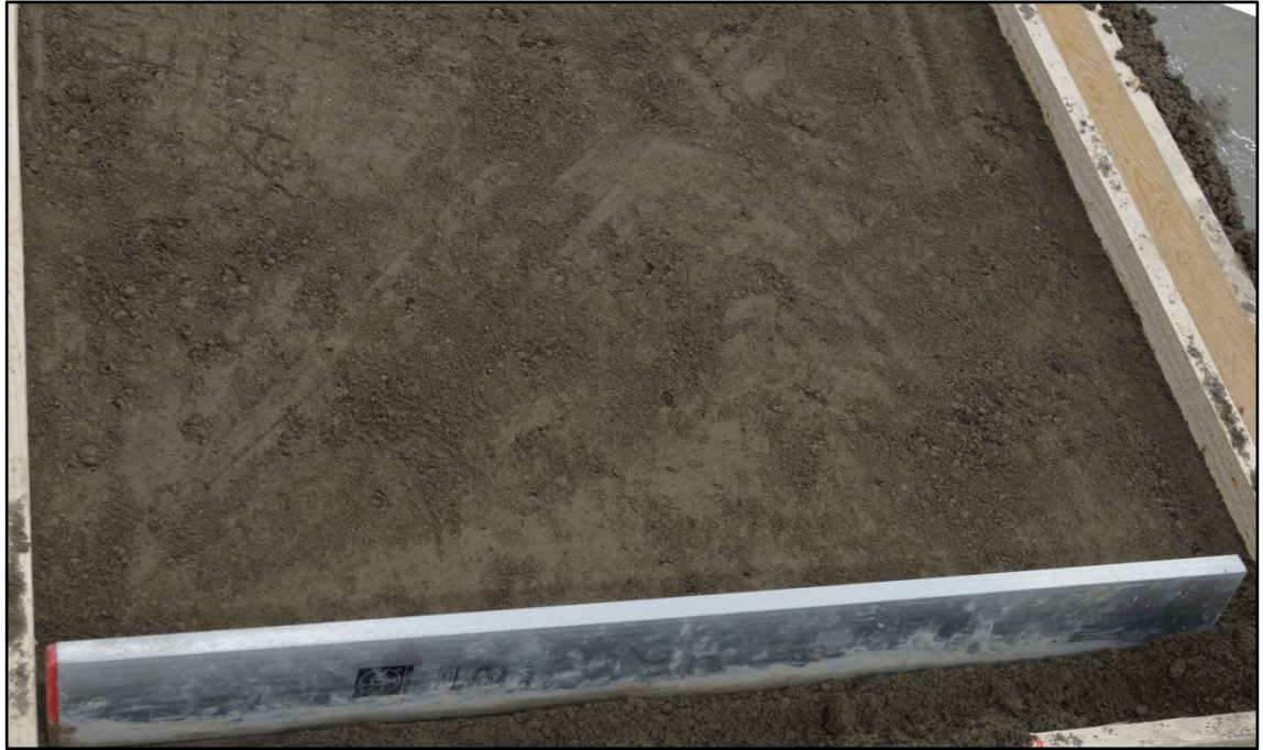
Kuva 8 Linjarilla tasoitetaan maakostean betonin pinta
