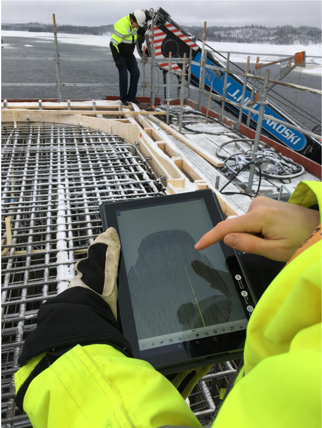
Kuva 9. Tietomallin käyttöä raudoitustarkastuksessa
