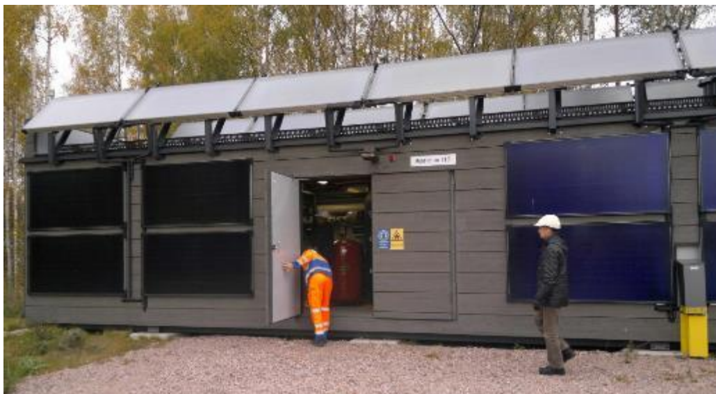
Kuva 6. Vipelentien aluelämpökeskus ulkokuva (Parviainen 2019)
