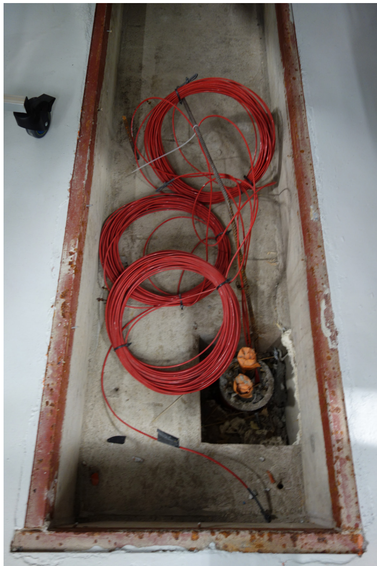
Kuva 5. Myllypuron kiinteistöön on rakennettu muiden muassa maailman parhaiten anturoitu energiakaivo.
