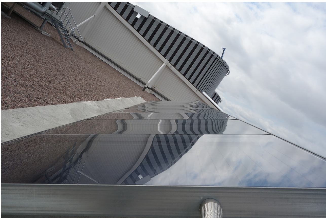
Kuva 4. Kampusen katolle on asennettu aurinkolämpökerääjiä, joita hyödynnetään sekä energiantehokkuuden maksimoinnissa että innovaatiotoiminnassa.
