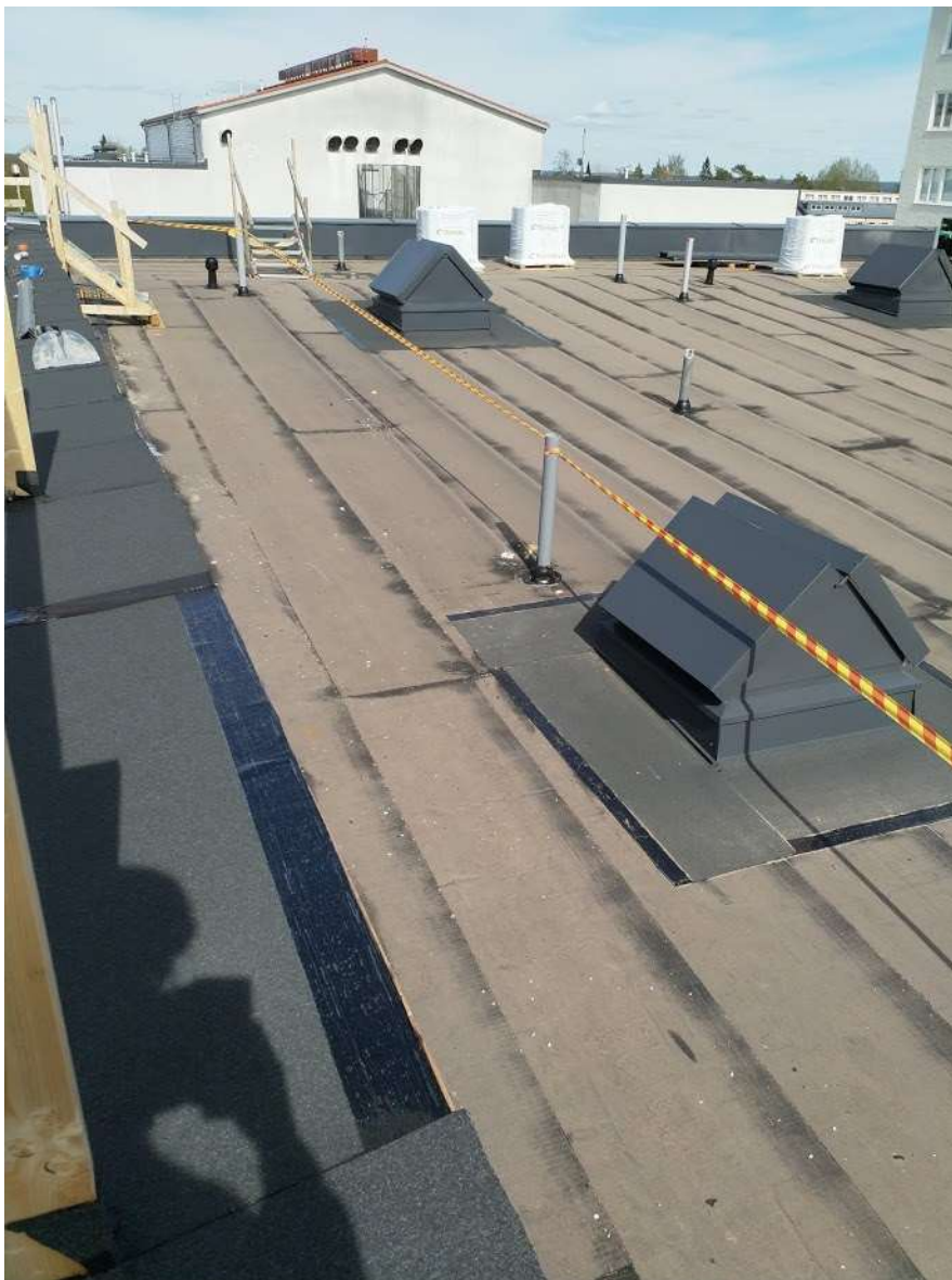
Kuva 6. Vesikatolla on kulku estetty putoamissuojaamattomilla alueilla lippusiiman avulla (Kuva: Riku Kummunmäki.)
