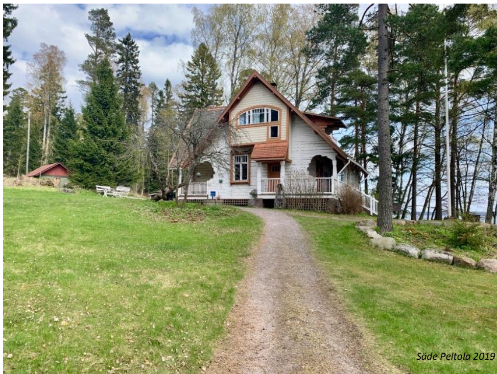
Kuva 2 Mäntyniemen leirikeskuksen päärakennus on peräisin 1890-luvulta
