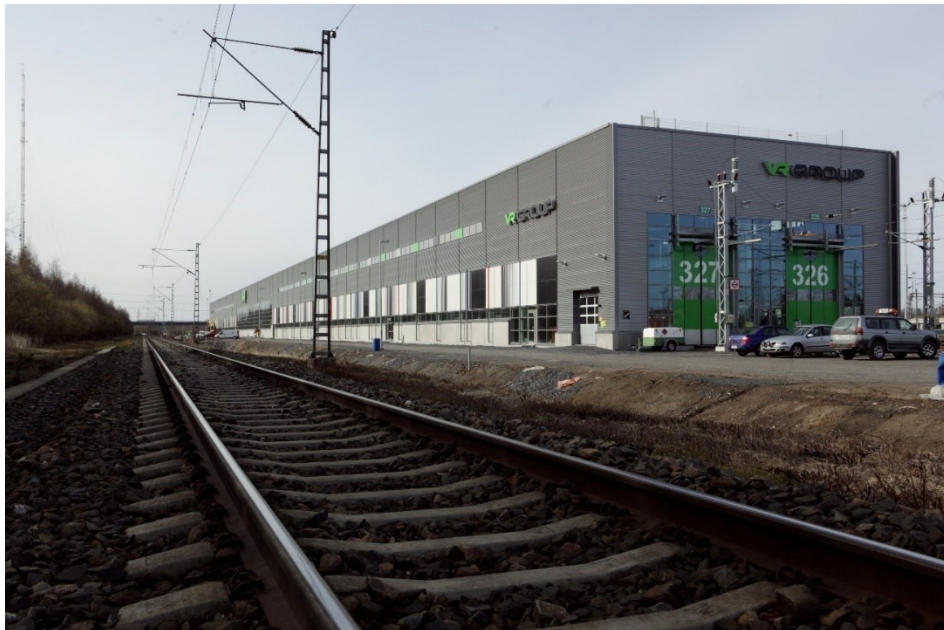
Kuva 6. Lopullinen päätös voittuneiden virroittimien vaihdosta tehdään VR:n operaatiokeskuksessa. Kuvassa VR:n Oulun varikko, jossa mm. sähköjunia huolletaan (VR Group, 2014)
