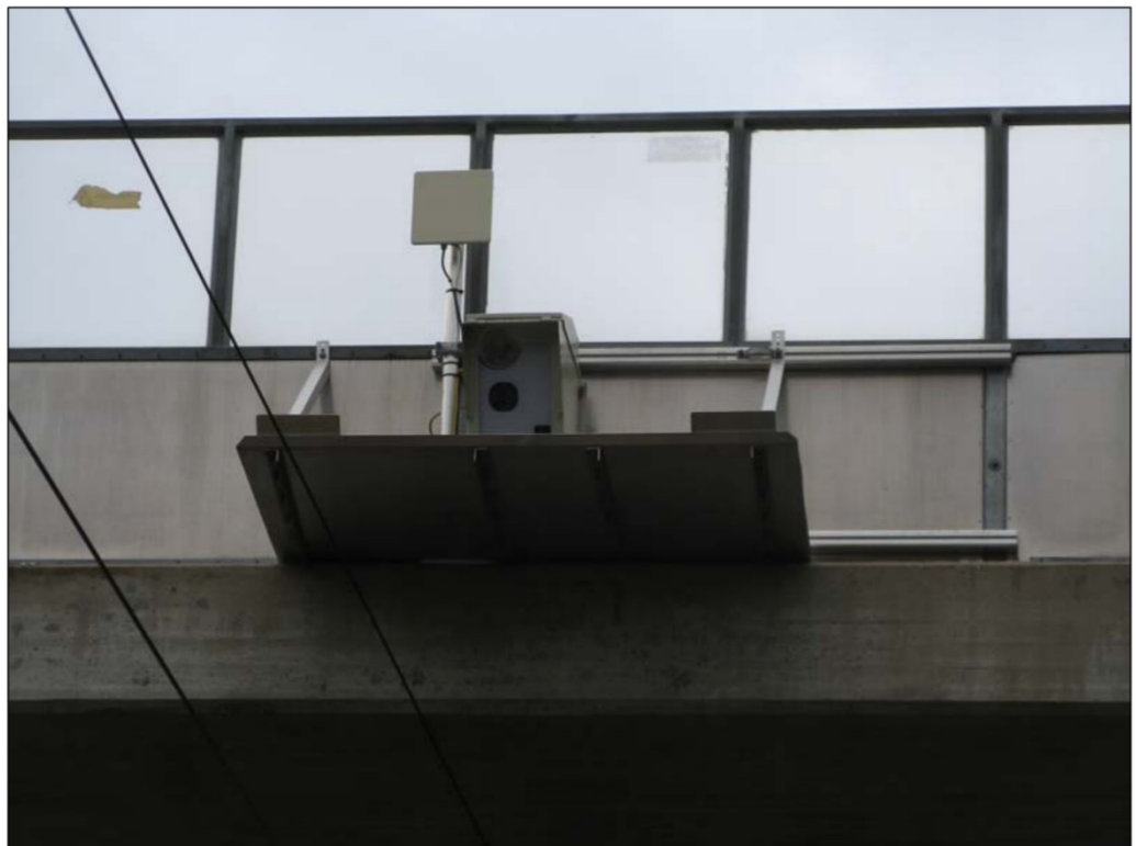
Kuva 4. Käytössä oleva APMS-virroittinkamera (Väylävirasto, 2014)
