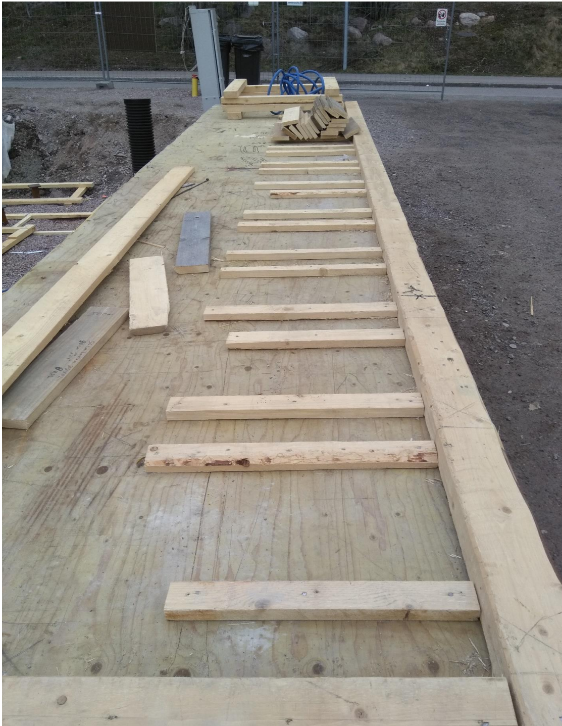
4. Työpöydän päälle tehty sapluuna. Rimojen väliin tulevat ensin pystylaudat puolen metrin välein
