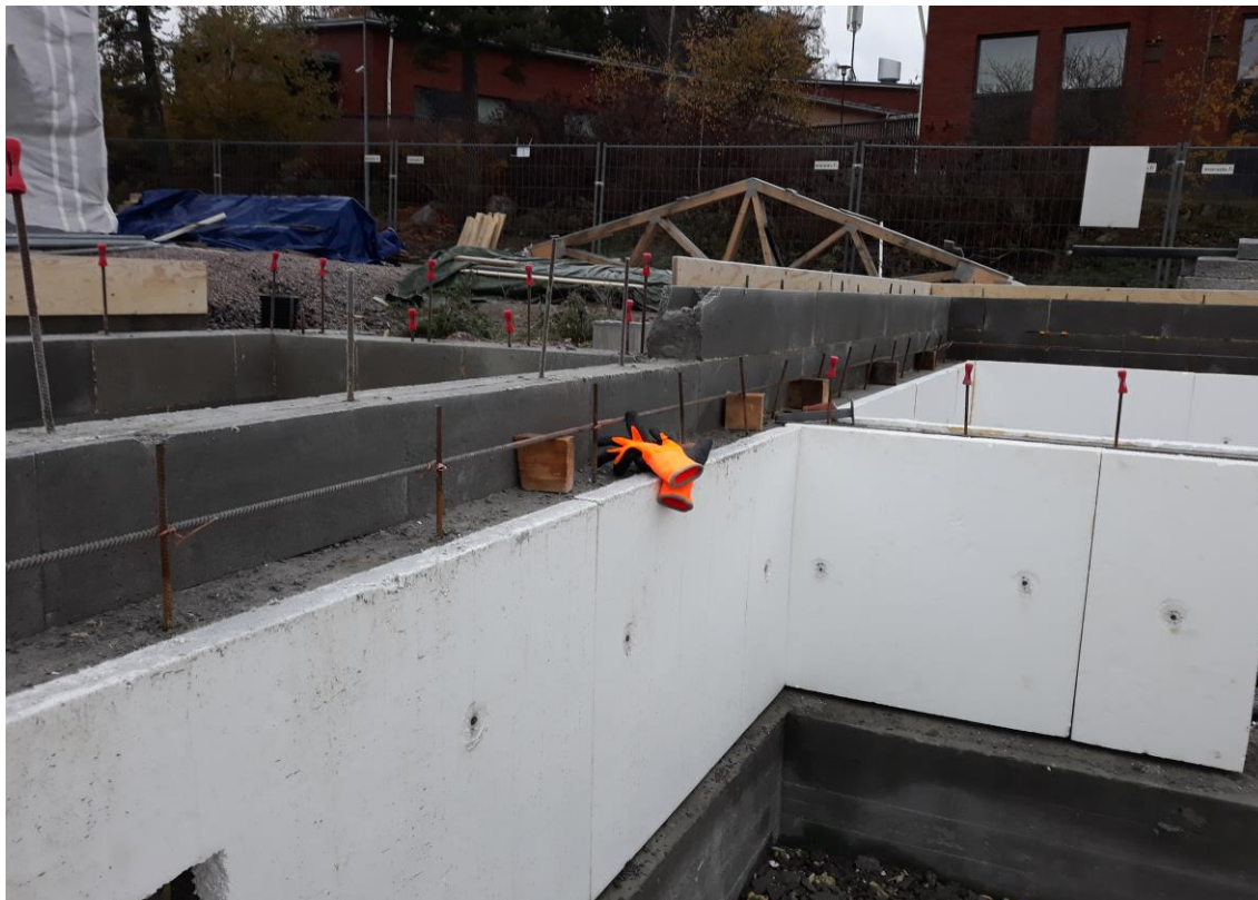
Kuva 9. Valmistelevat työt ennen laattojen asennusta. Raudoitus, vaneri, styrokseksi.
