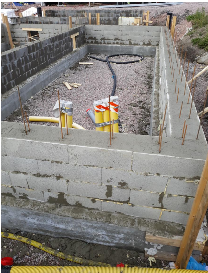
Kuva 7. Sokkeli ensimmäisen betonoinnin jälkeen.
