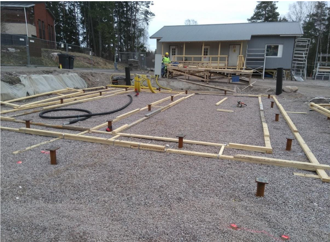
Kuva 1. Alajuoksujen asennus. Kuvan oikeassa alakulmassa kiinniottopuu valumuotin ulkopuolella. Kiinniottopuu on lyöty harjateräksellä maahan kiinni.
