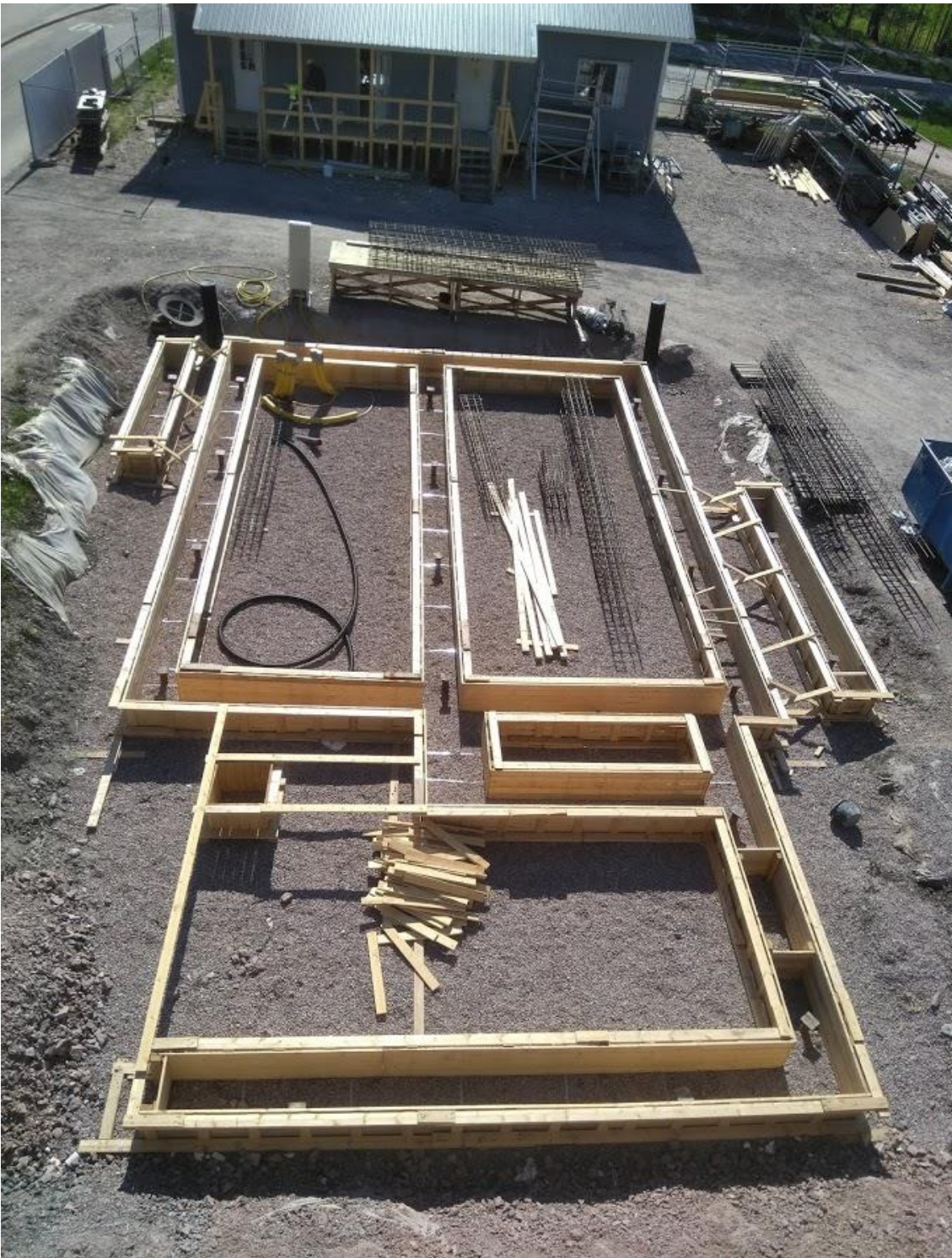
Kuva 2. Anturan muottityöt valmiina raudoitusta varten
