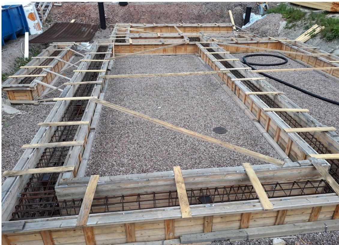
Kuva 4. Antura tarkistettuna ennen betonointia
