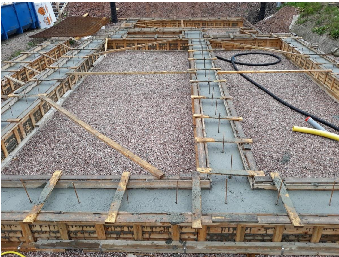
Kuva 5. Antura betonointityön jälkeen
