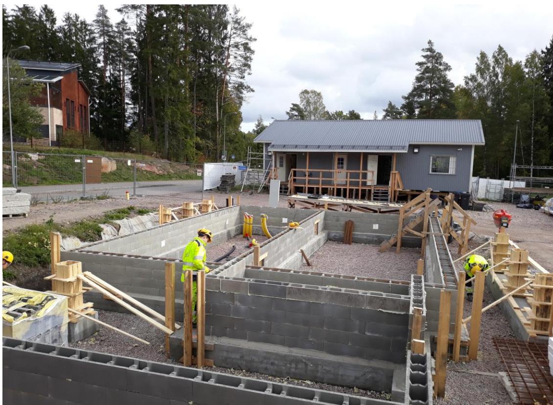
Kuva 6. Sokkeli ennen harkkojen betonointia
