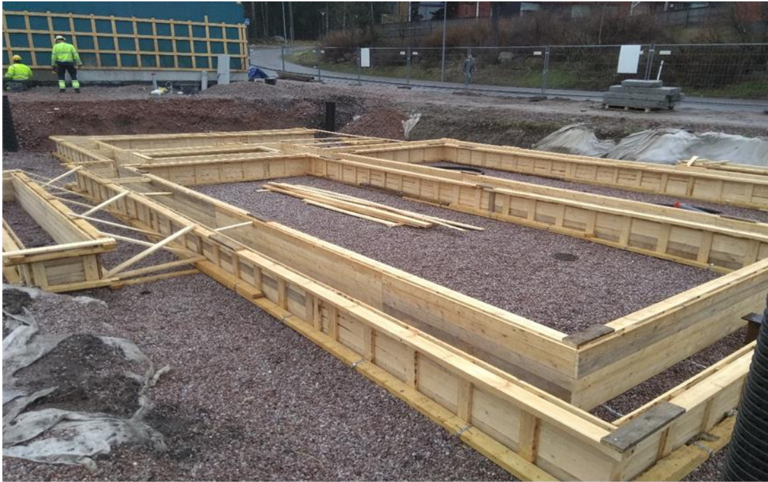
7. Anturasiivut paikoillaan yläjuoksut, asennettuina
