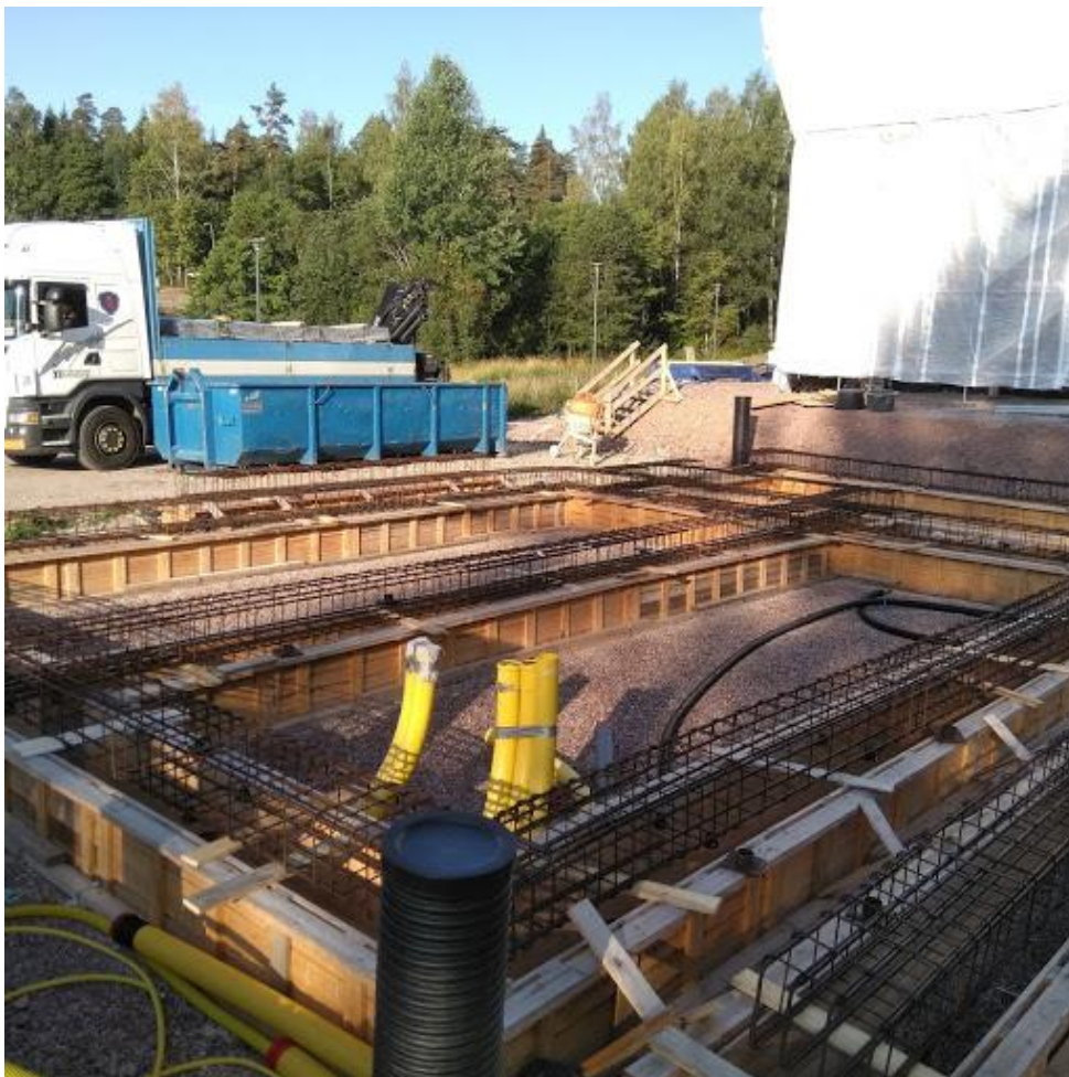
8. Raudoitus asennettu anturan päälle
