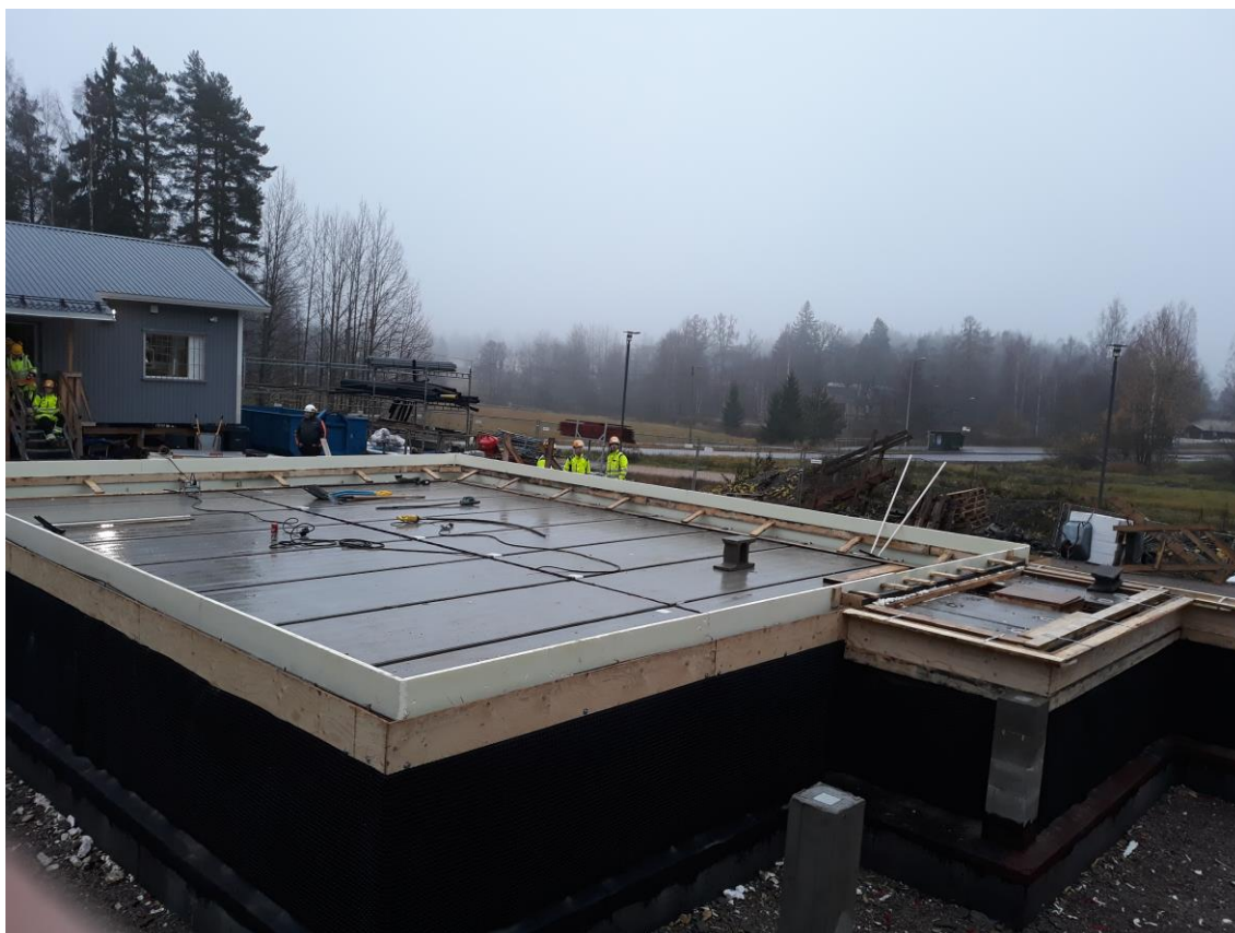
Kuva 8. Sokkelin korotuksen muotti valmis
