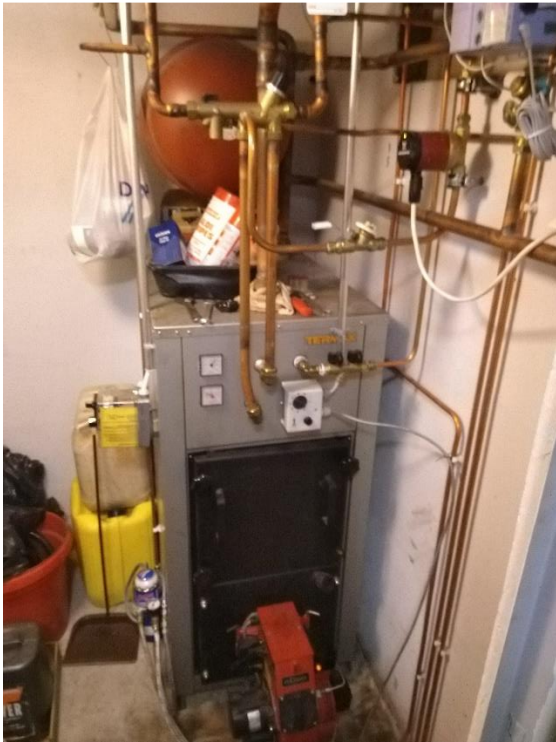
KUVA 6. Heiton talon nykyinen öljykattila
