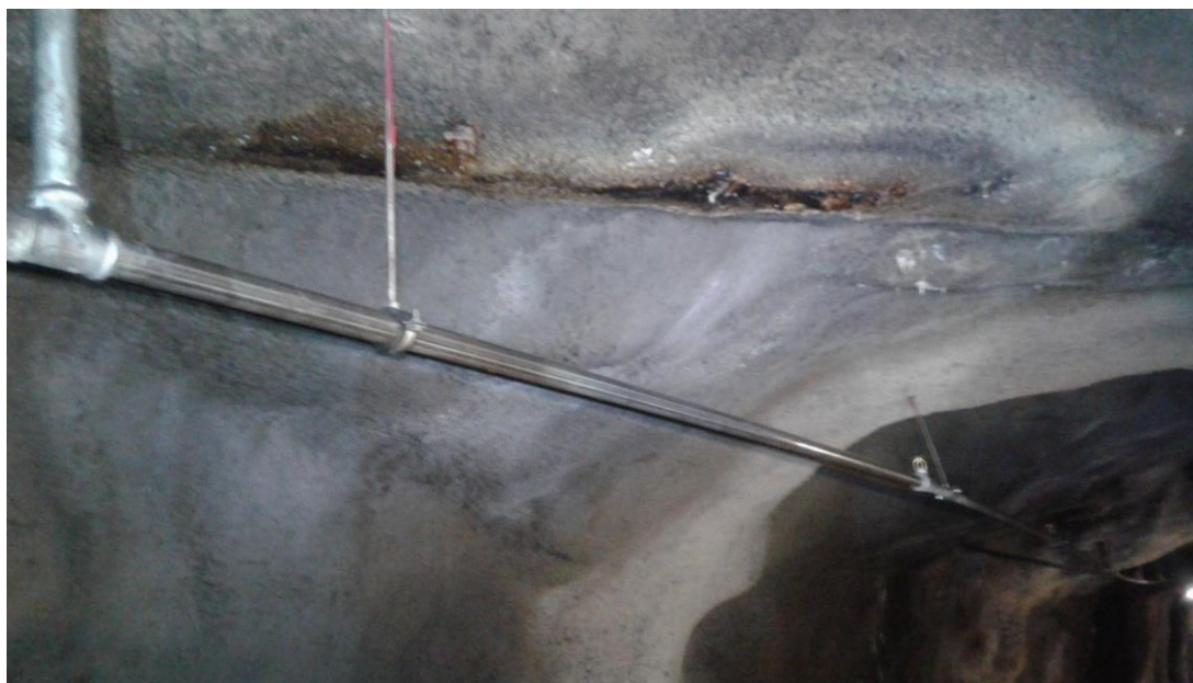
Kuva 11. Uusittua sprinkleriputkistoa.
