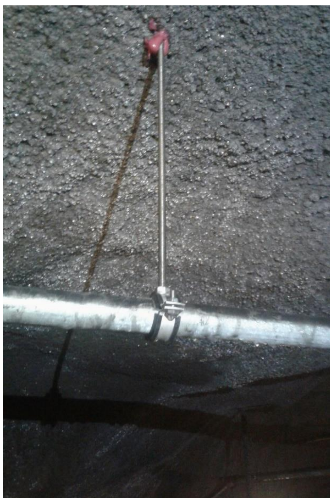
Kuva 9. Uusittu putkipidin, jossa on kumitiiviste.
