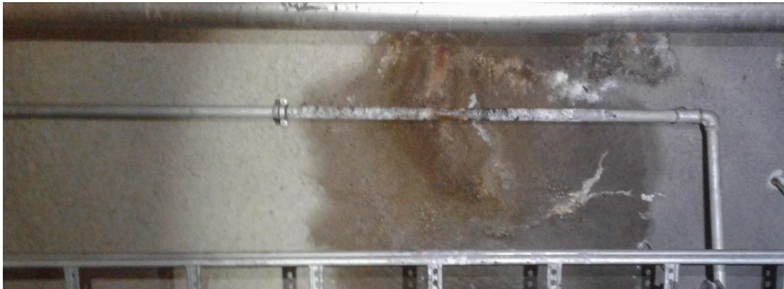
Kuva 6. Korrosioitunutta putkistoa.
