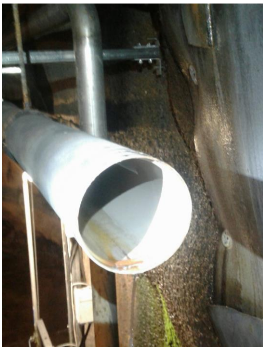
Kuva 7. Avattu sprinklerijärjestelmän runkoputki.
