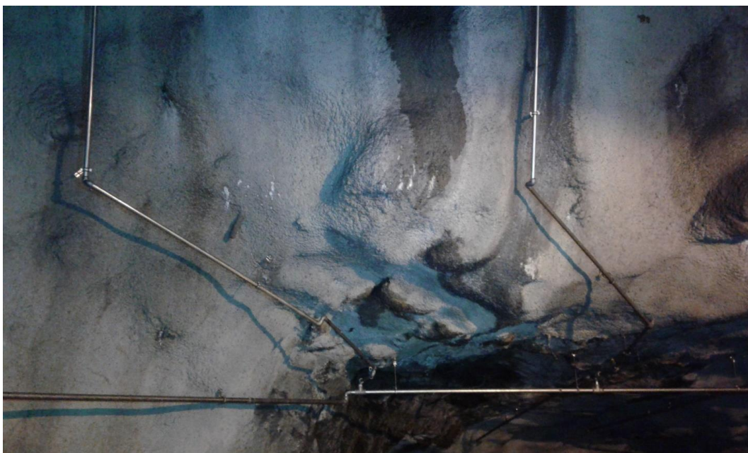
Kuva 12. Tunnelin päädyn uusittua putkistoa
