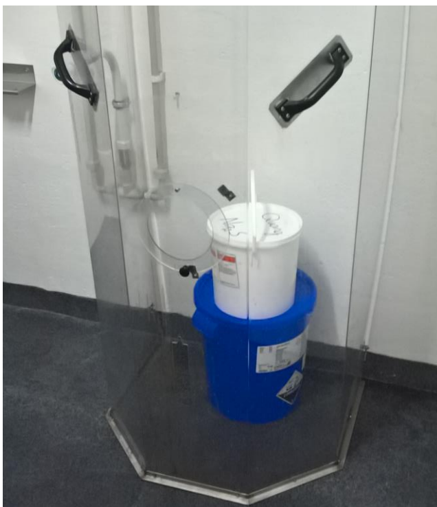
Kuva 33. Reaktorin polykarbonaattisuojuus. Suojuksen sisällä olevia astioita on käytetty reaktoritankin tyhjennyksessä.
