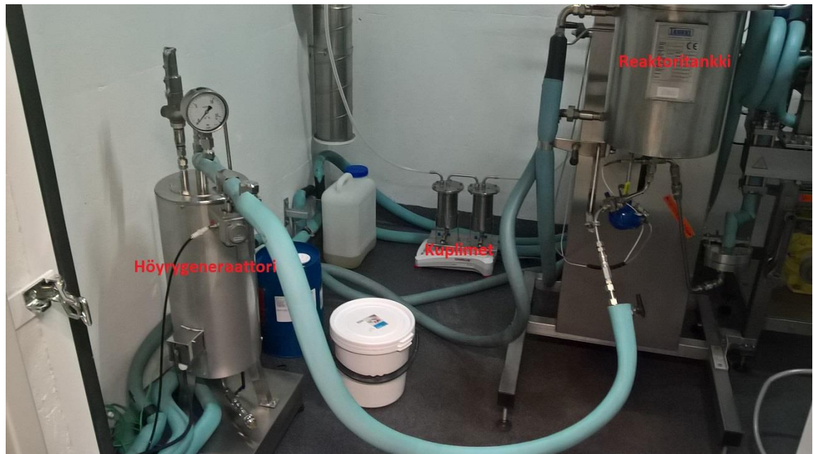
Kuva 2. Höyrygeneraattori kytkettynä reaktoritankkiin esihydrolyysiprosessin aikana.
