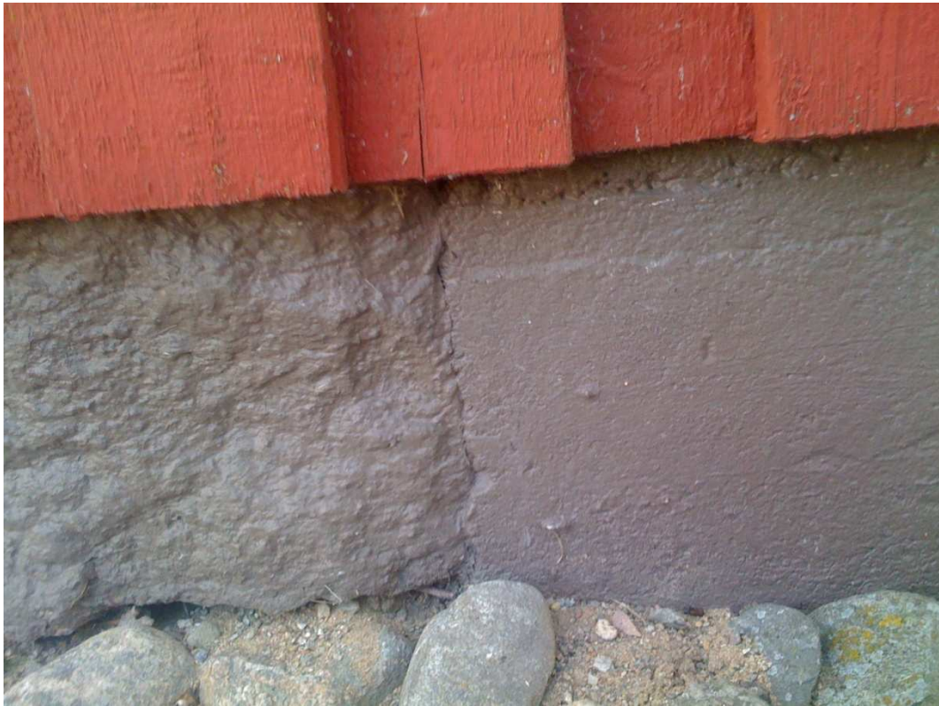
Kuva 3. Porakivi- ja betoniperustuksen liittymäkohta.
