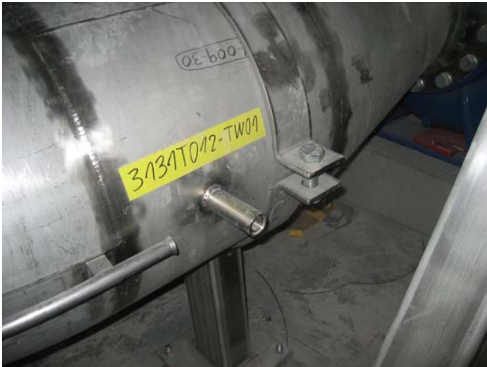
Kuva 12. Kierteellinen lämpötilanmittausyhde.
