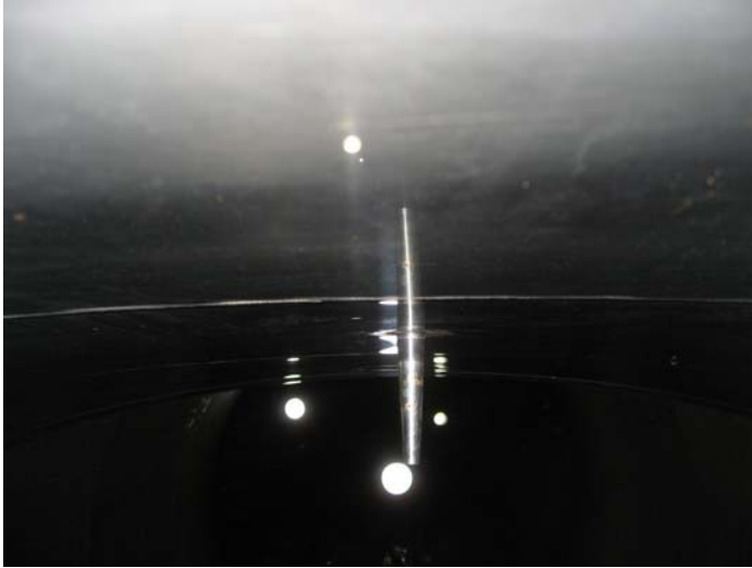
Kuva 11. Tornin sisäpuolella oleva lämpötilamittauksen suojatasku.
