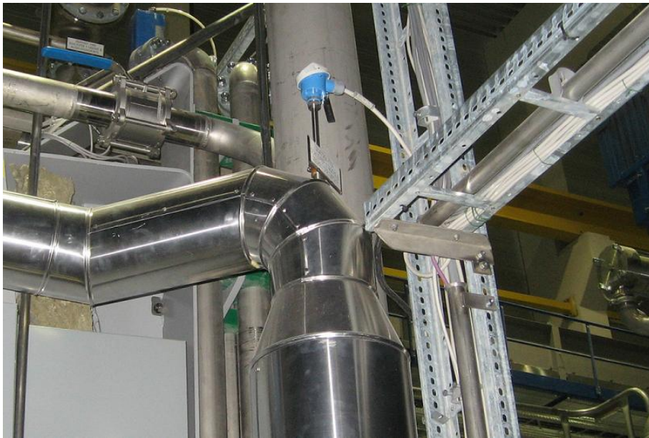
Kuva 9. Putkikäyrään asennettu lämpötilan mittaus.
