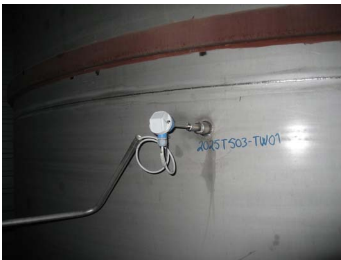
Kuva 10. Tornin ulkopuolelle oleva lämpötilan mittaus.
