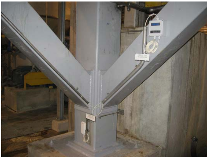
Kuva 27. Pinnankorkeuden mittaus suoritetaan venymäliuska-anturia hyväksi käyttäen.
