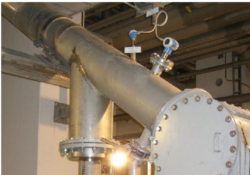
Kuva 5. Kuvassa näkyvät lämpötilan ja paineen mittaus massaputkessa. Painemittaus on liitetty prosessiin laippaliitännällä. Lämpötilan mittaus on asennettu myötävirtaan, koska mittaus suoritetaan massaputkesta.
