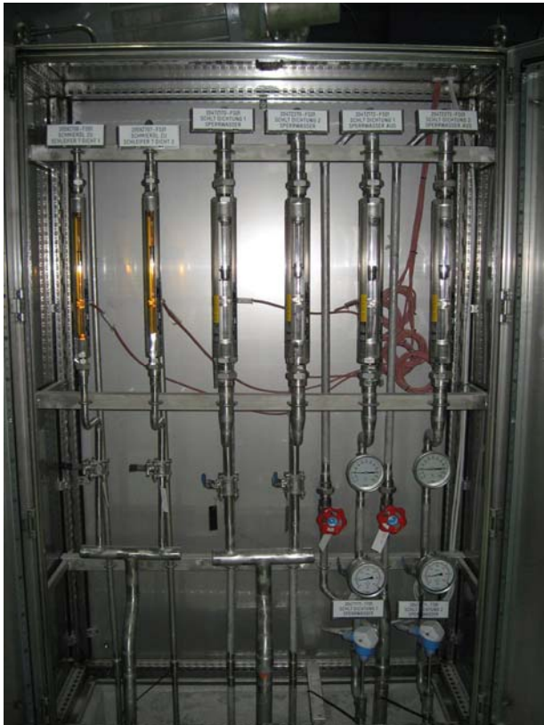
Kuva 20. Uimurivirtausmittareita.
