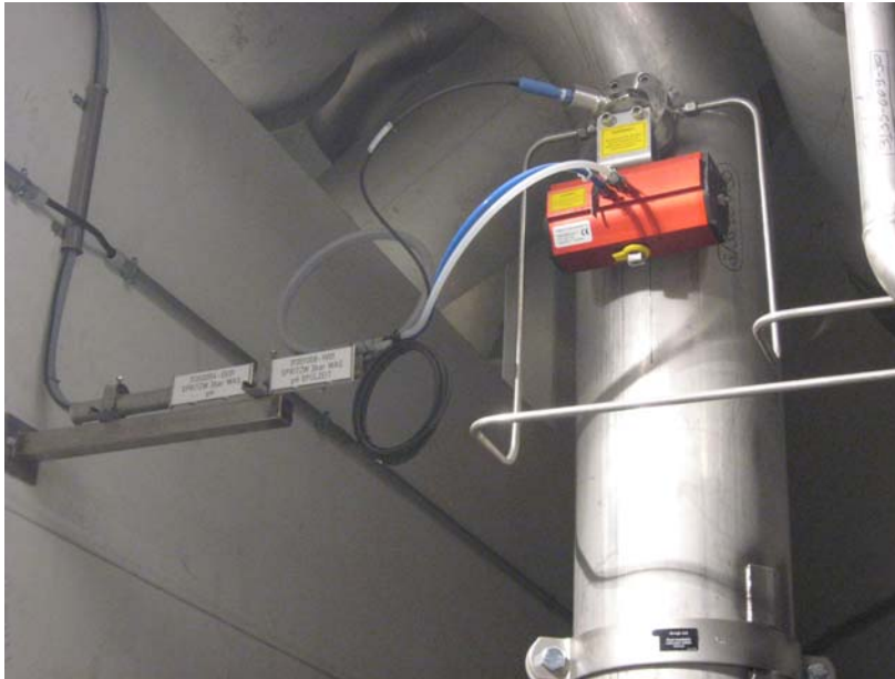
Kuva 29. pH-mittauslaite varustettuna automaattisella huuhtelulla.
