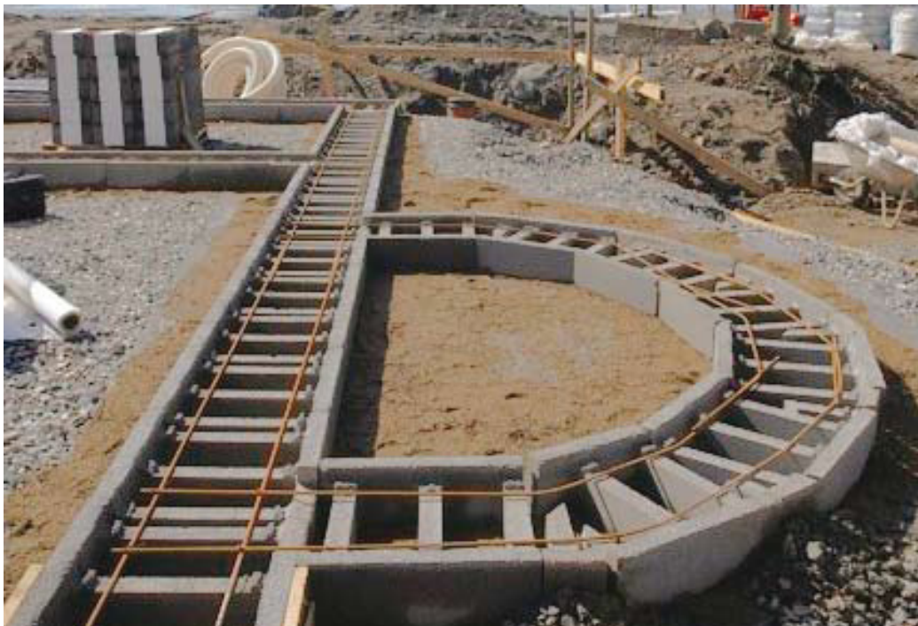
Kuva 6 Kevytsoraharkkoista tehty anturamuotti. (Betonikeskus)
