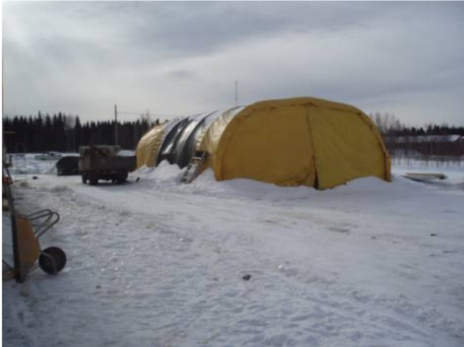
Kuva 15. Sääsuoja valmistelevia töitä varten.
