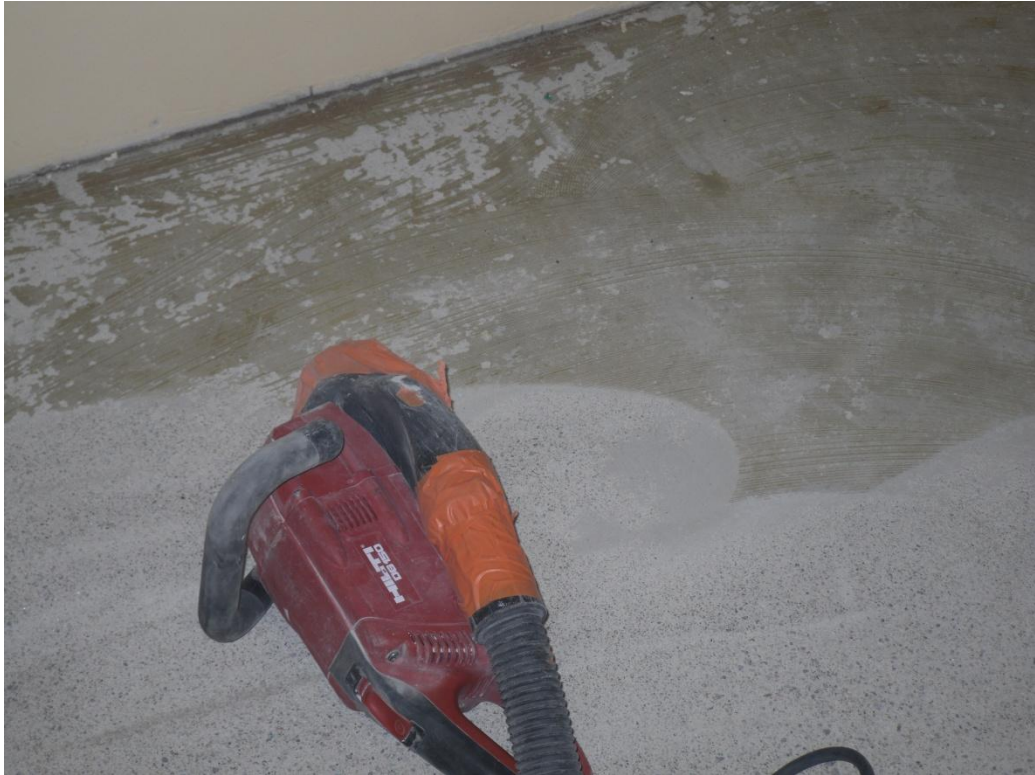
Kuva 6. Hiomakone on liitetty imuriin, joka vähentää pölyn syntymistä.
