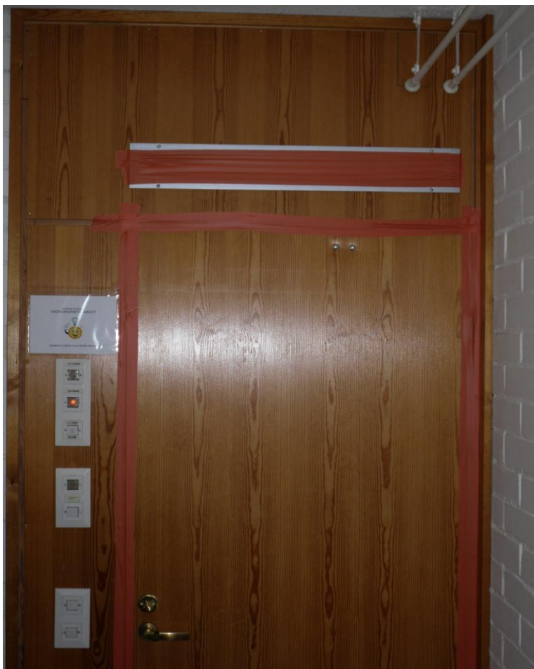
Kuva 2. Työmaan rajoittava ovi tiivistetään teipillä.
