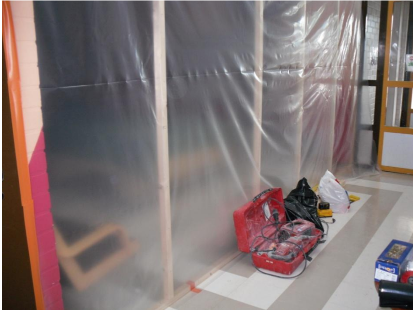
Kuva 1. Suojaseinä korjattavan ja käytössä olevan tilan rajassa.
