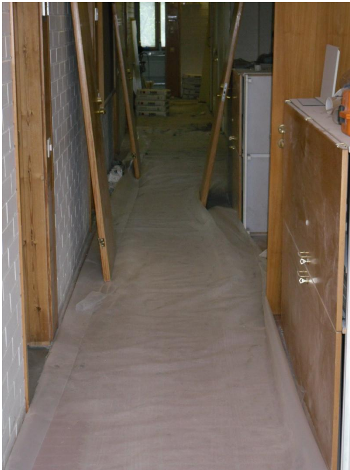
Kuva 4. Lattia on suojattu korjaustyön aikana.
