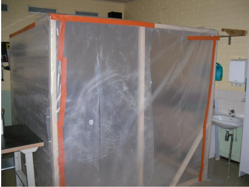
Kuva 3. Pienen kohteen osastointi omalla "suojakopilla".
