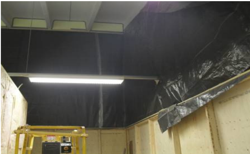
Kuva 8. Ensimmäisen lohkon lisäosan suojaseinä työmaan puolelta katsottuna.
