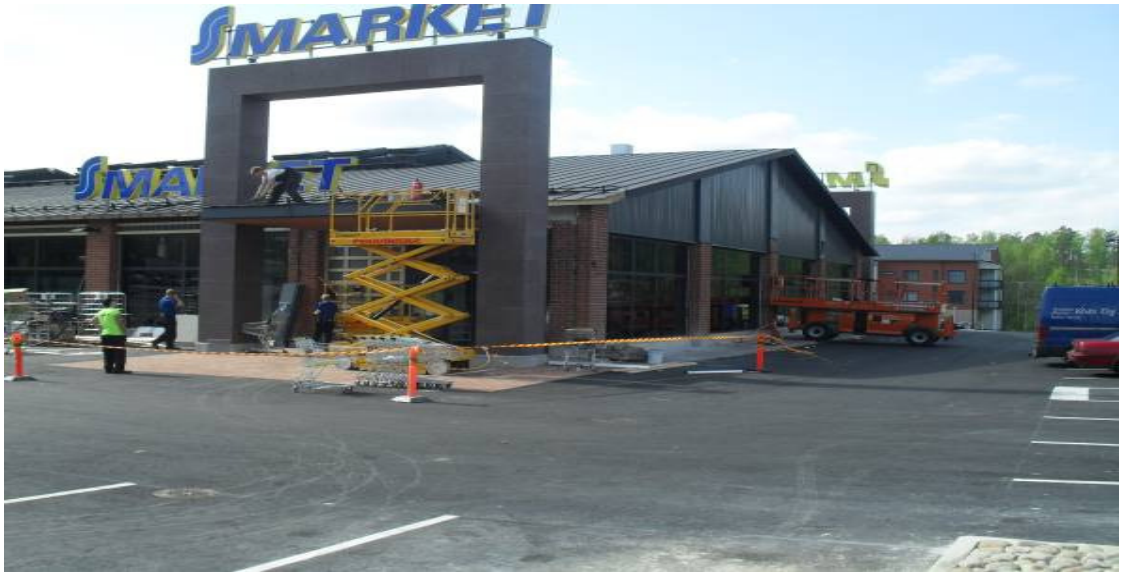
Kuva 9. Vanhan sisäänkäynti työn alla.
