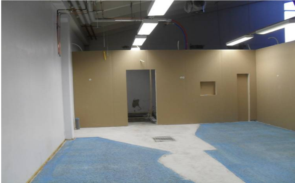
Kuva 4. Uuden pullohuoneen seinät levytettynä. Oviaukosta näkyy tuulikaapin lattiavalu.
