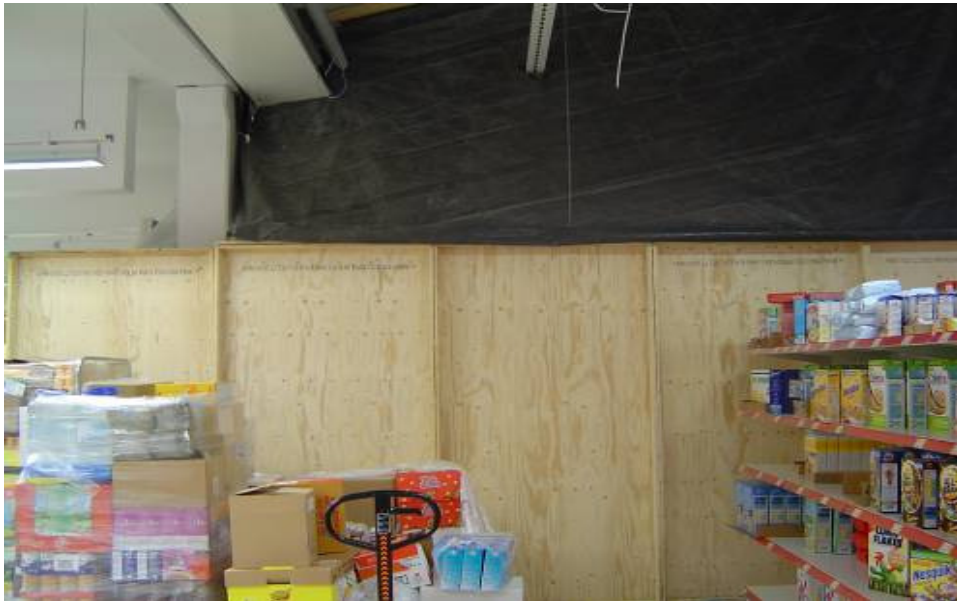
Kuva 3. Urakoitsijan toteutus suojaseinästä. Seinän alaosa on tehty tukevaksi turvallisuussyistä. Yläosa seinästä on lähinnä pölyn leviämisen estävä.
