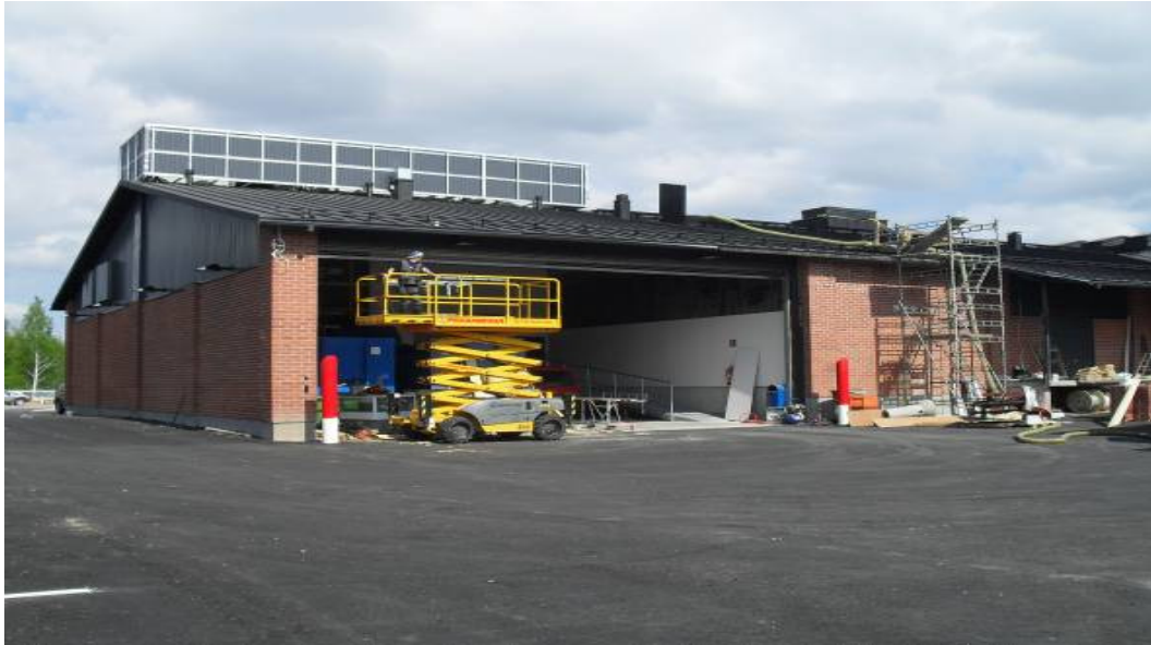
Kuva 7. Lastaustilan oviaukko takapihalla kohteen viimeistelyvaiheessa. Katolla näkyvät iv-koneiden lauhduttimet.
