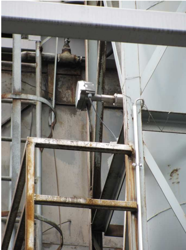
Kuva 22. Esimerkki langattoman hiukkaspitoisuusmittarin asennuksesta.
