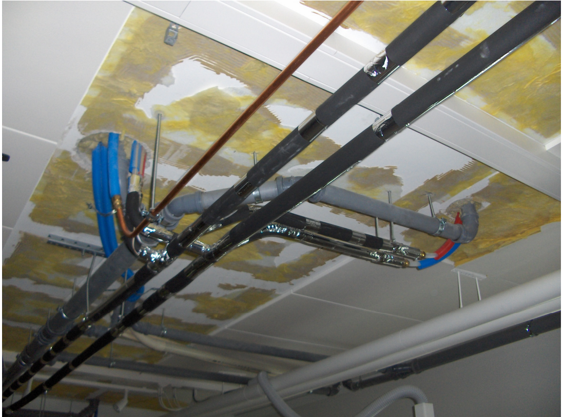
Kuva 8: Lämpimenoja hammashoitoyksikön alla (työnaikainen tilanne)
