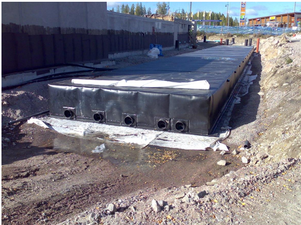
KUVIO 6. HDPE-kalvolla tiivistetty viivytytysallas
