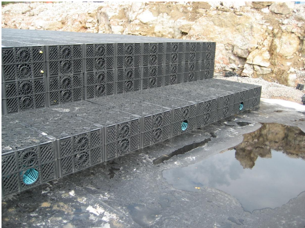
KUVIO 1. Hulevesikasettijärjestelmä asennusvaiheessa
