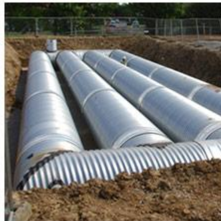
KUVIO 4. Putkipatteristo huleveden viivytykseen (Tubosider 2010)
