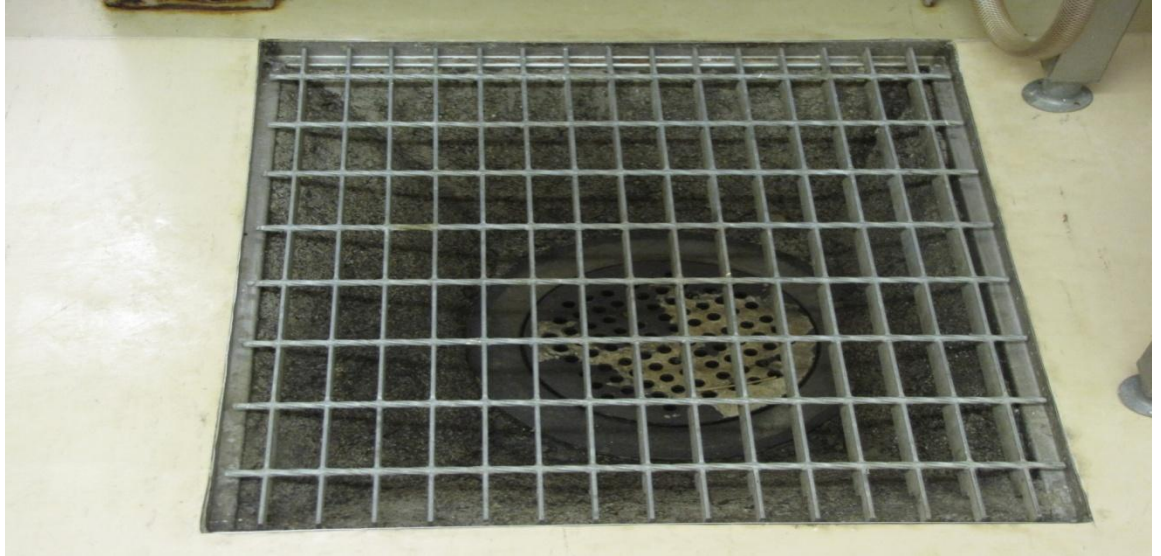
Kuva 3. Käylän leirikeskuksen keittiön kävelyritilällinen lattiakaivo.
