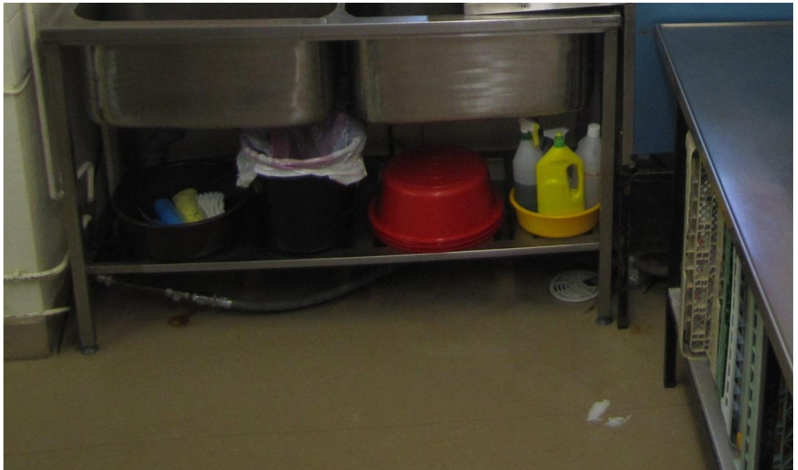
Kuva 4. Käylän leirikeskuksen keittiön astianpesupisteen lattiakaivo.
