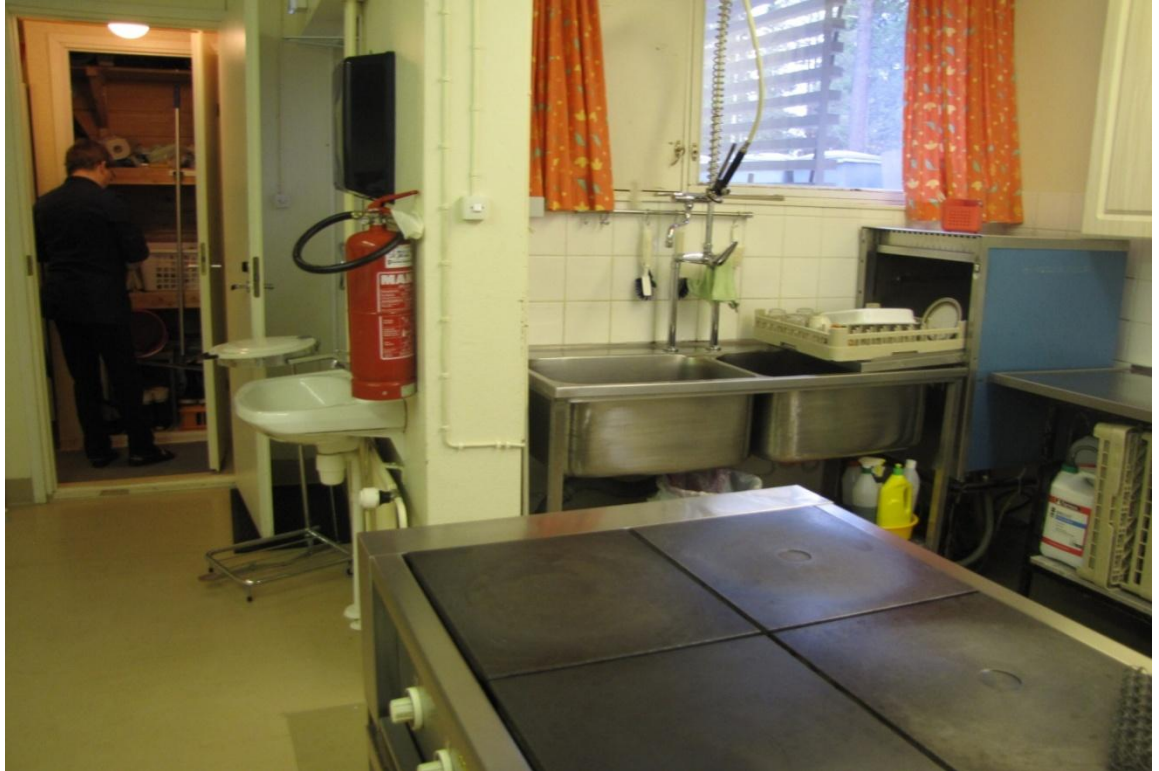
Kuva 2. Käylän leirikeskuksen keittiön käsiensuallas ja astioiden esipesuallas.
