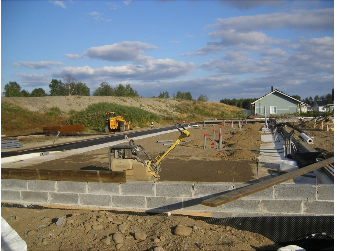
KUVA 8. B-talon alustäytöt ovat valmiit. Huoneistokohtaisten viemäreiden asennus on käynnissä.
