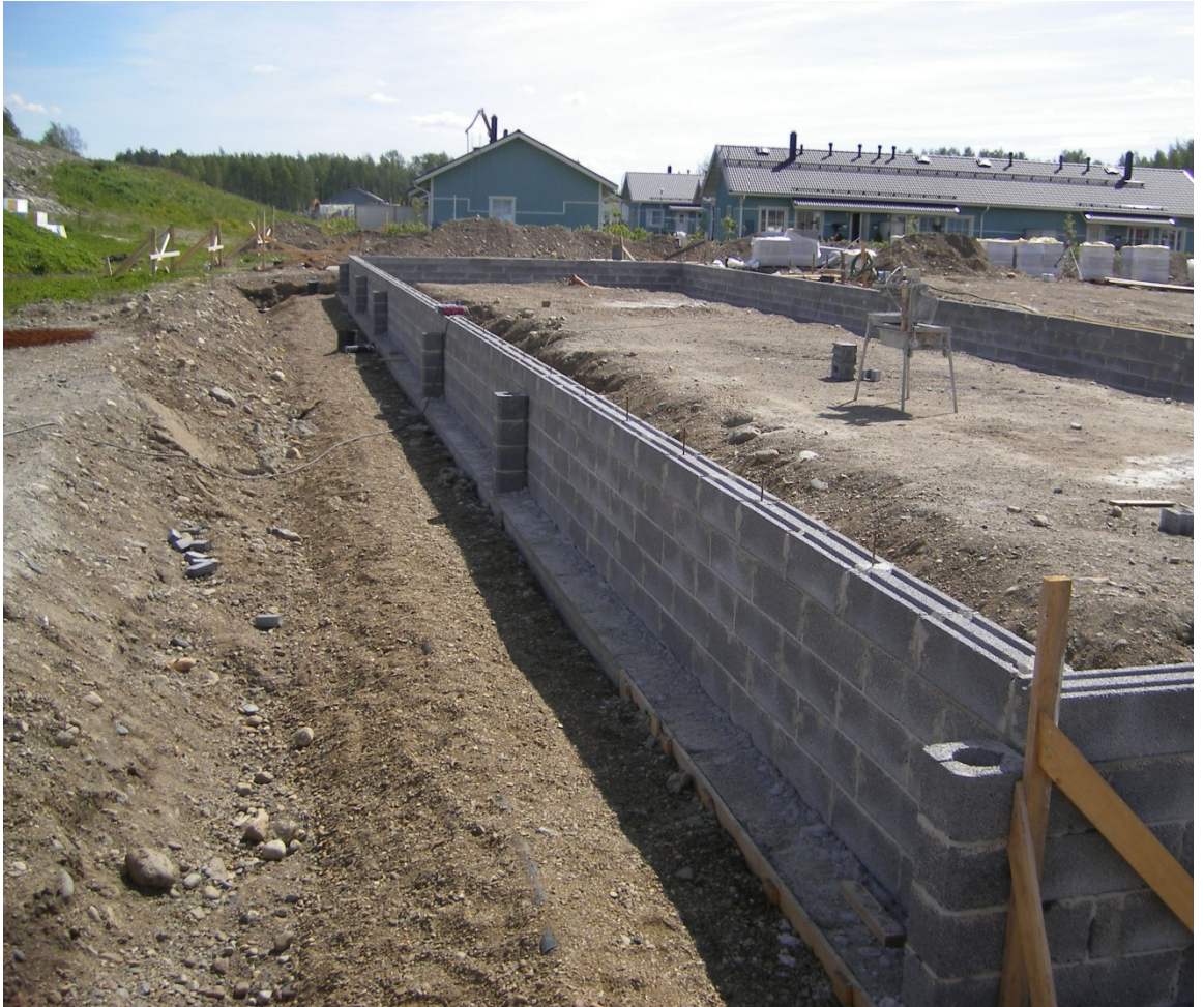
KUVA 3. Talo B, sokkelin muuraus on valmis.
