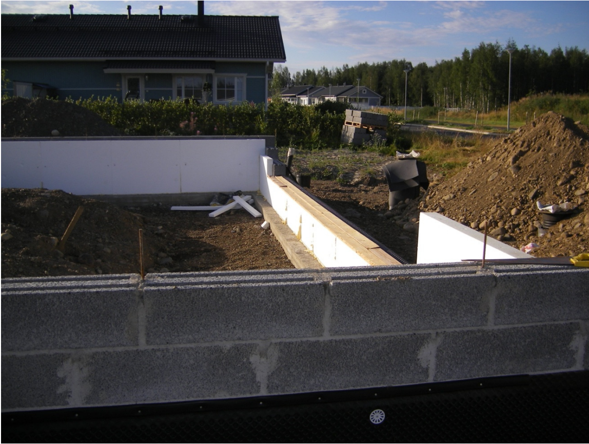
KUVA 4. C-talon sokkelin aukko suojattuna.
