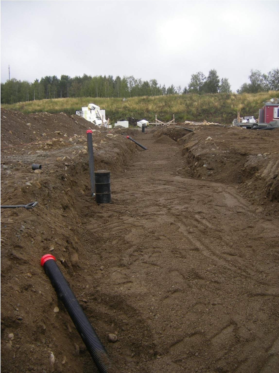
KUVA 2. Kaivanto anturalle, talo C. Sadevesi- ja salaojaputkistot on jo asennettu.
