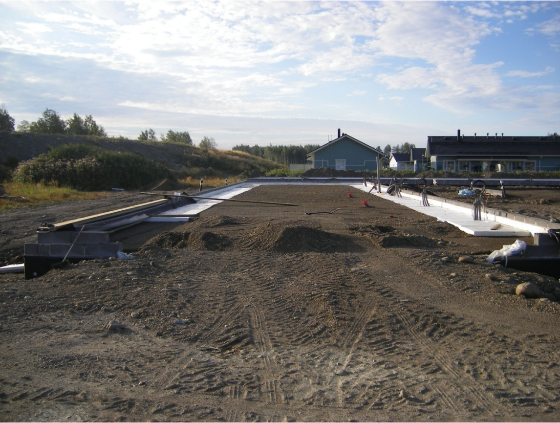
KUVA 7. B-talon viemärin päälinja on asennettu ja täytöt ovat päätyä vaille valmiit.
