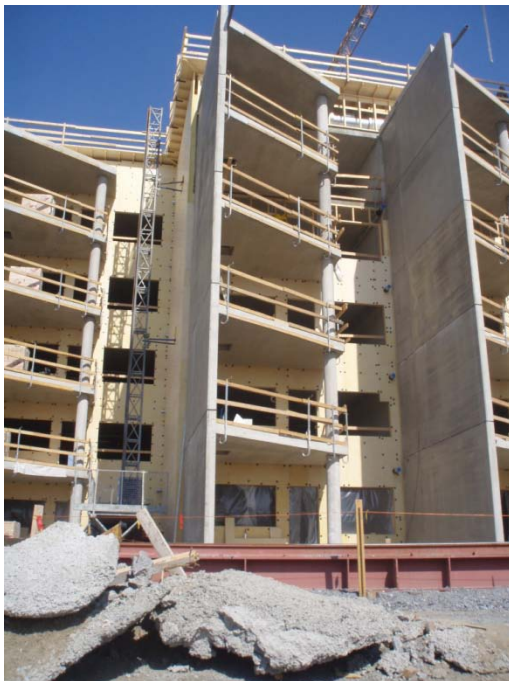
KUVA 4. Putoamissuojaus Joona Kokkonen 2010
