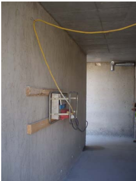
KUVA 5. Oikein sijoitettu jakokeskus Joona Kokkonen 2010
