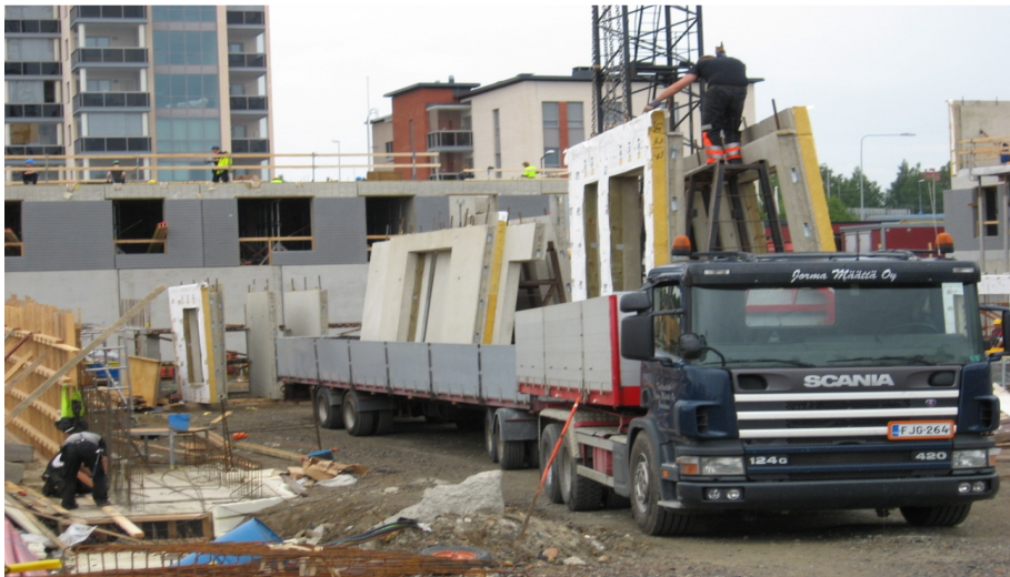
Kuva 4. Elementtien saapuminen työmaalle.
