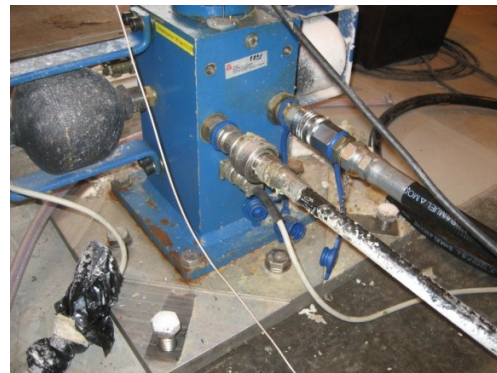
Kuva 8. Hydrauliiikkaletkut ja mittausliitin.
