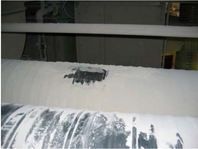
KUVA 11. Pölyä putkistojen päällä.
