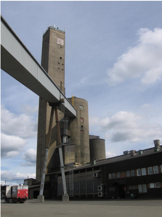
Kuva 2 Pyhäsalmen kaivoksen rikastamo
