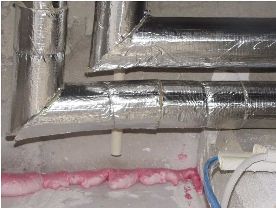
Kuva 6 Kuvassa näkyy palosuojaavaahdolla tehdyt paikkaukset. Samassa kuvassa näkyy kuinka putket on eristetty.
