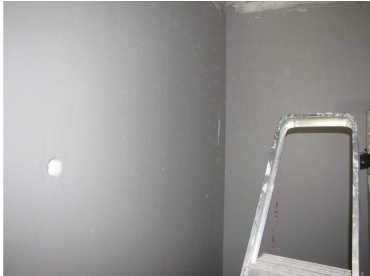
Kuva 9 vedeneristyksellä käsitelty huone
