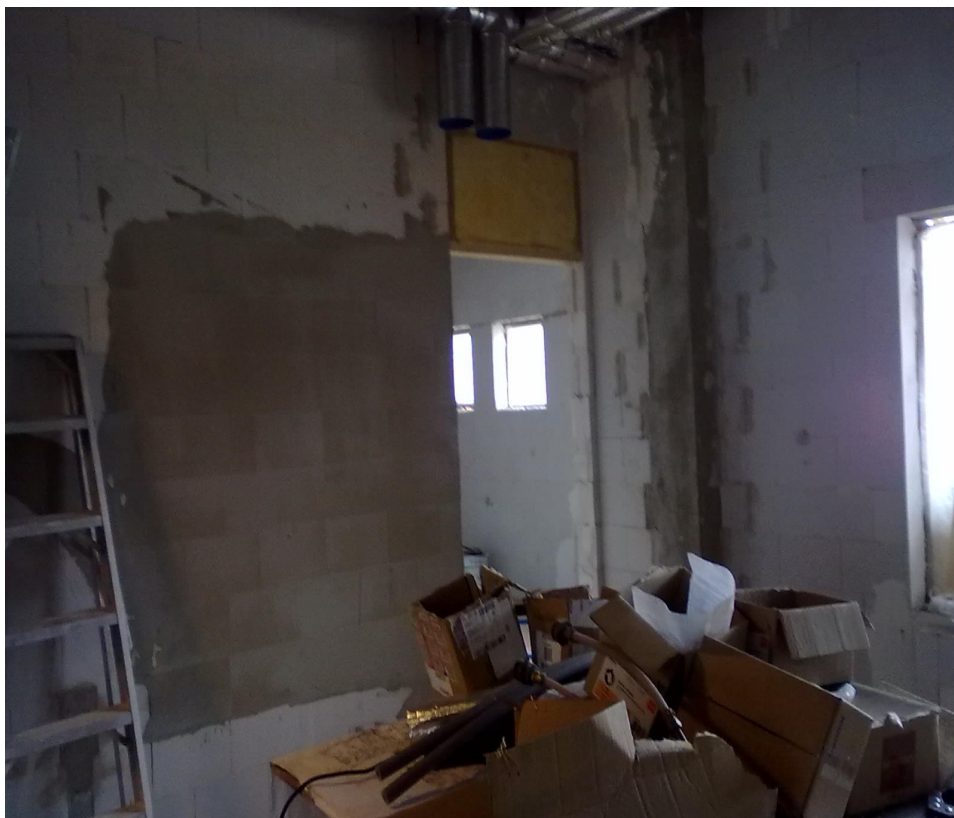
Kuva 7 Osa seinästä on tasoitettu märäntilan tasoitteella
