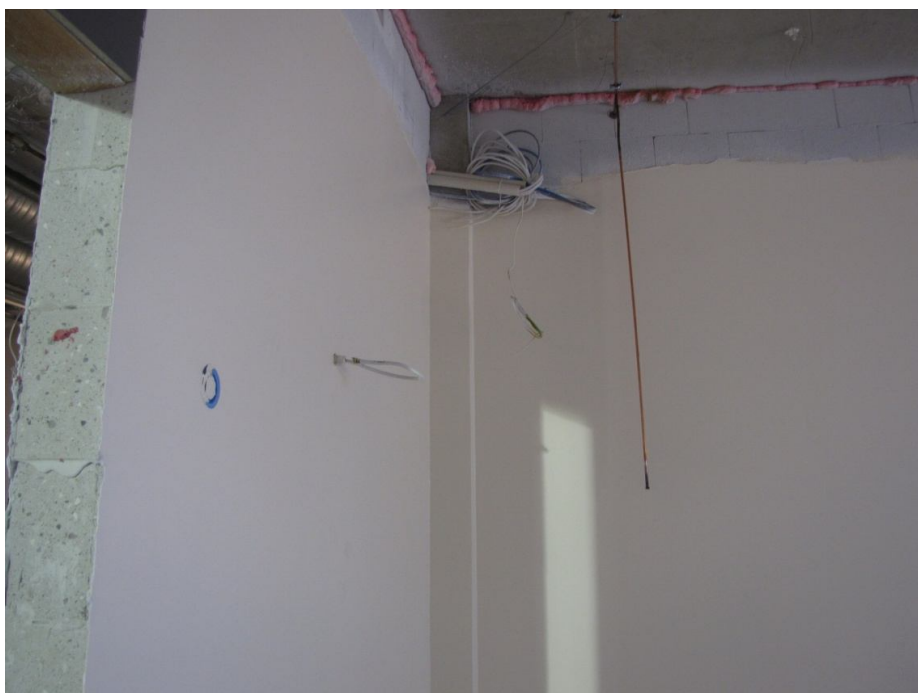
Kuva 8 Kuivan tilan tasoite seinässä
