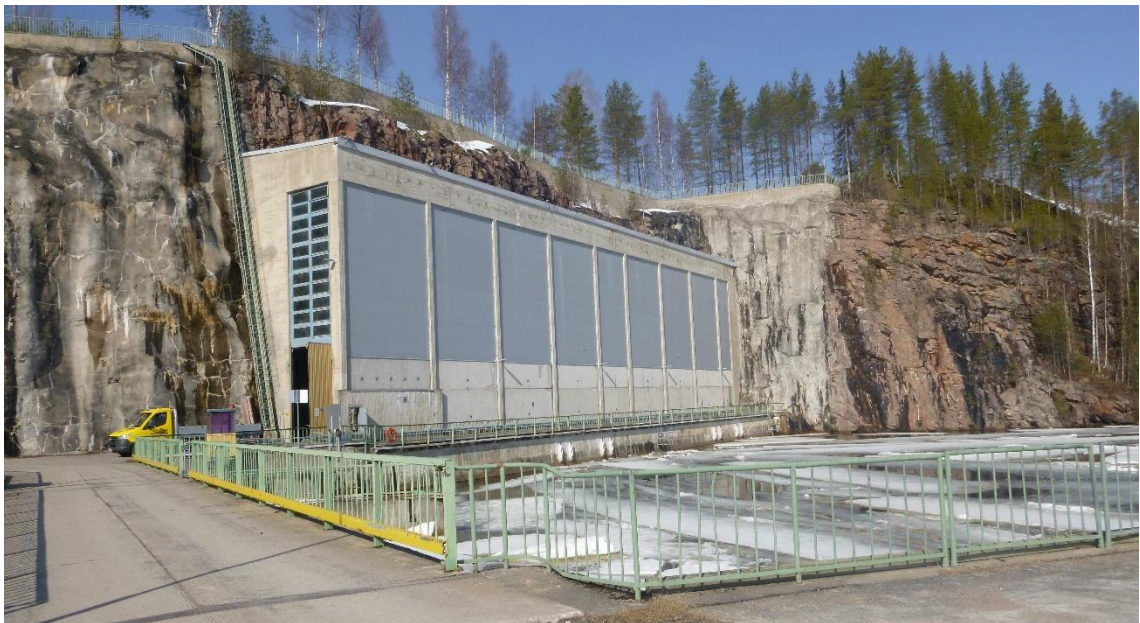
Kuva 3 Voimalaitoksen luukkusali ja kaapelireitit kalliota pitkin
