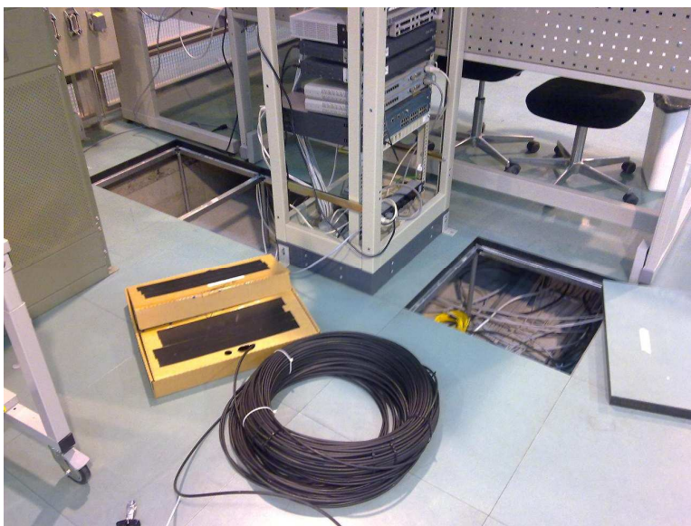
Kuva 18. Kuitunipun asennus ja suojalaatikko vikatilanteille
