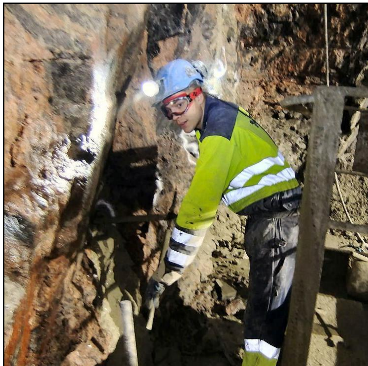
Kuva 3. Naamiomalliset suojalasit injektoitaessa → oikein-havainto.
