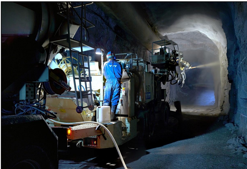
Kuva 41. Ruiskubetonointia. Perämiehellä ei näkyvää suojavaatetusta.
