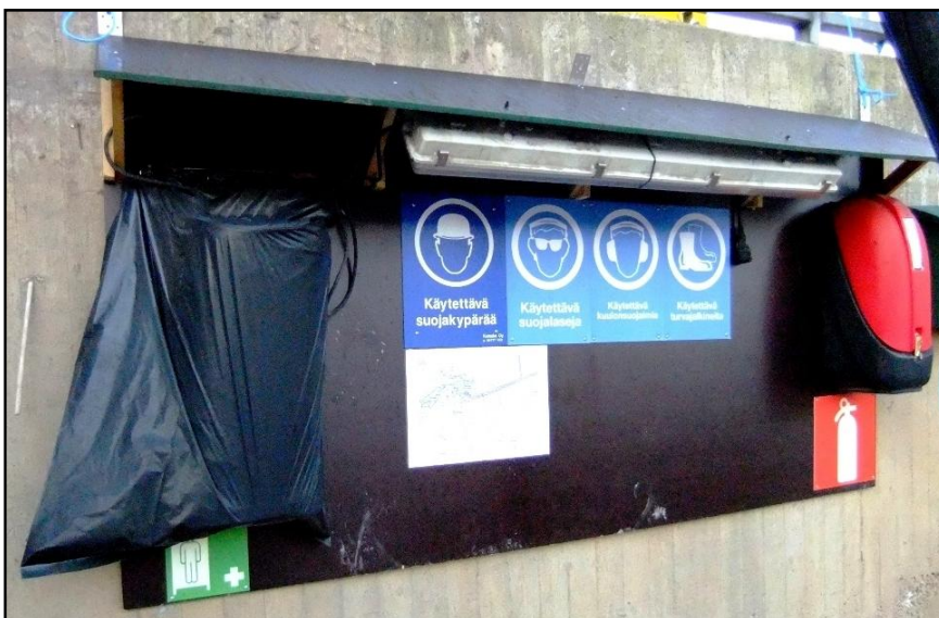
Kuva 18. Turvamerkkien käyttöä työmaalla.
