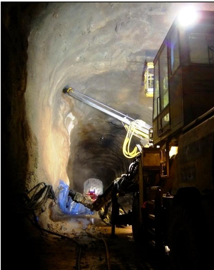
Kuva 39. Pulttinreikien porausta. Puomin kohdalla oleva vykki ja muuntaja suojattu vedeltä.
