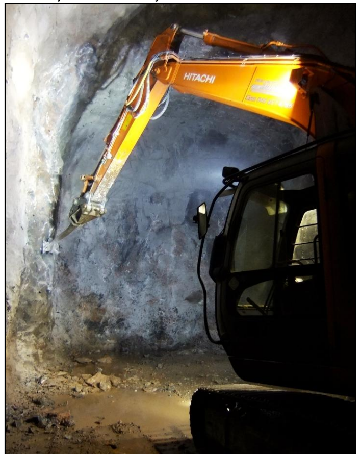
Kuva 40. Räjätetyn kohteen lähialue rusnattava tarpeeksi kaukaa, ei pelkästään räjäytettyä katkoa. Seinät ja katkonrajat rusnattava myös huolellisesti.
