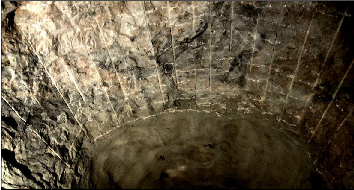
Kuva 16. Jälkirusnattu tunneli, joka lujitettu harjateräspulteihin sekä osittain jo ruiskubetonoitu.
