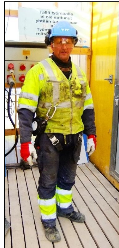
Kuva 26. Varustus kuilutöihin. Valjasliivit, säädetty sopivaksi ja kelautuva tarrain.
