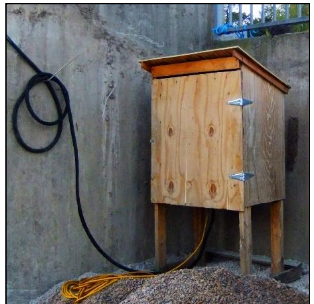
Kuva 8. Työmaakeskus ripustettu, suojaus myös ulkopuoliselta ilkevallalta ja varkauksilta → oikeinhavainto.
