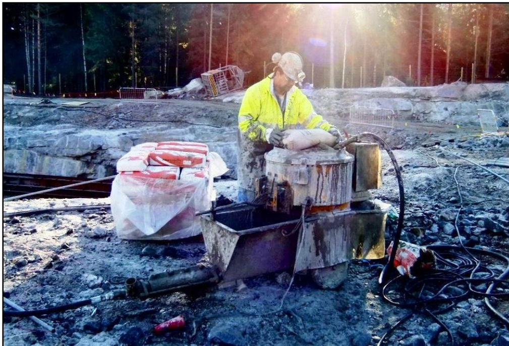
Kuva 25. Säkkien nosto ja käsittely jämerää sekä huolellista. Hengityssuojainta tulee käyttää, vaikka ilmavirta käy työntekijän takaa.
