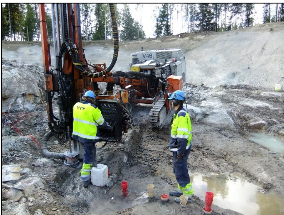
Kuva 43. Vaunuporausta. Työympäristö siisti, kaivannon luiskat tuettu ruiskubetonoinnilla. Tarvittavat suojavaälineet käytössä. Vaunu kunnossa.
