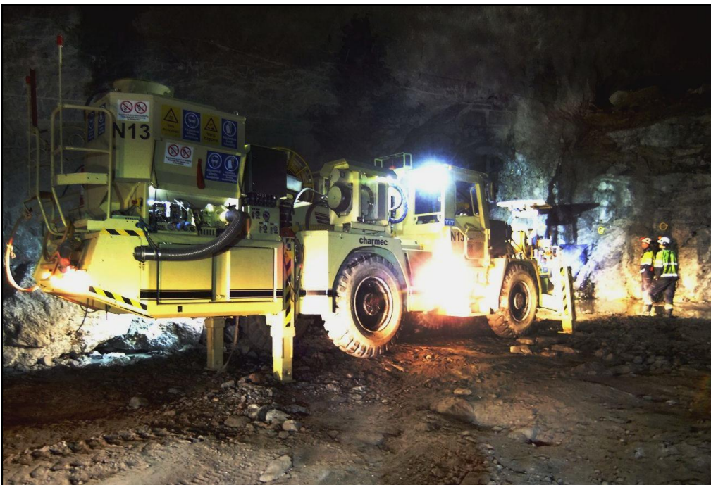
Kuva 29. Panostusalustan yleiskunto hyvä, valaistus, varoitusmerkinnät. Työskentelymaasto ja koneen tuenta.
