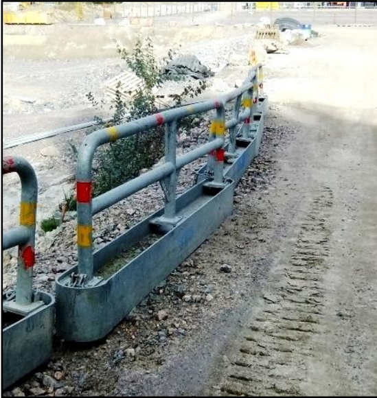
Kuva 14. Raskas suojakaide. Helppo siirtää, nopea asentaa paikoilleen, eivät kaatuile omia aikojaan, suojaa myös ajoneuvokalusta putoamiselta.
