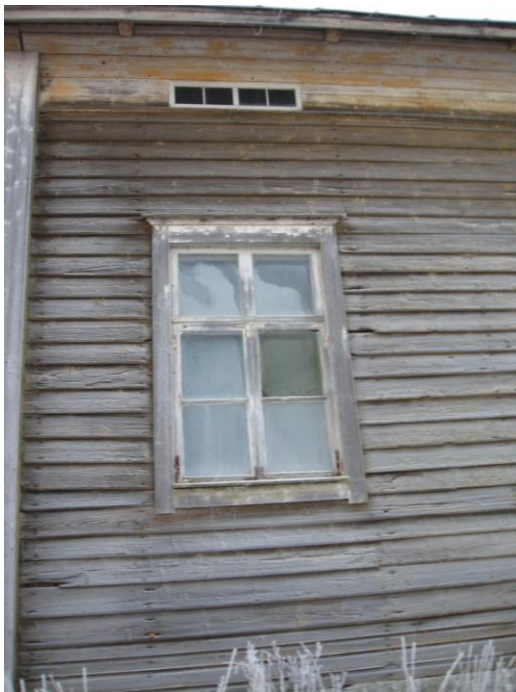
Kuva 11. Alakerran kuusiruutuinen ikkuna, jonka yksi ruutu on vanhaa vihreää lasia. Yläpuolella vinttilojen haukkaikkuna.
