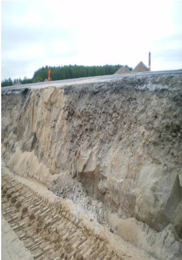
KUVA 1. Maaleikkaus Valtatie 8:n työmaalla
