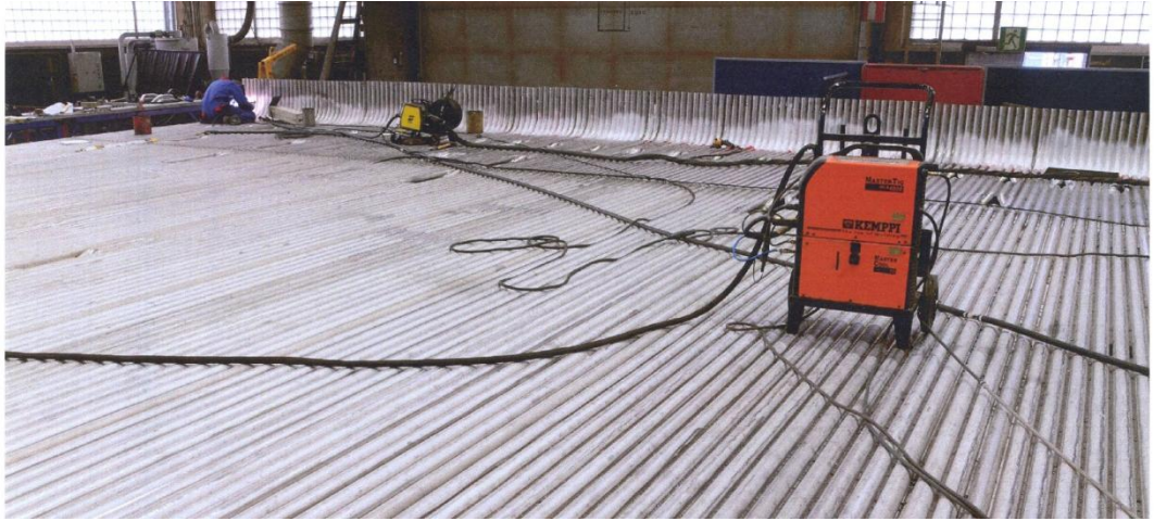
Kuva 7. Kirkkaan seinän kokoonpanovaihe (Warkaus Works Oy 2010)
