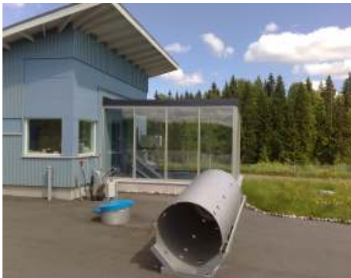
KUVIO 4. Pilot-laitoksen huoltorakennus.
