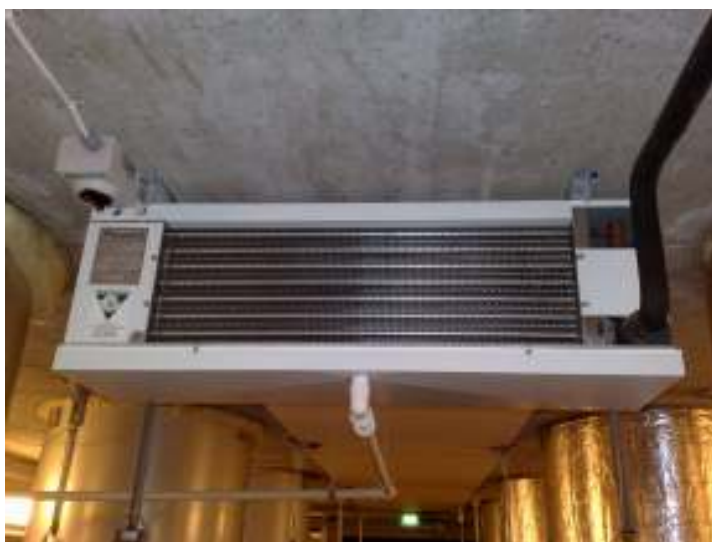
KUVIO 8. Jäähdytyslaitteiston höyrystinyksikkö. (Ryynänen 2010.)
