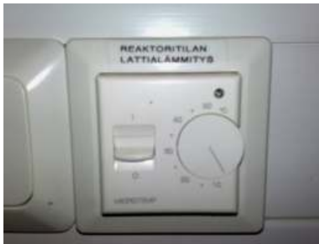
KUVIO 9. Lattialämmityksen termostaatti. (Ryynänen 2010.)
