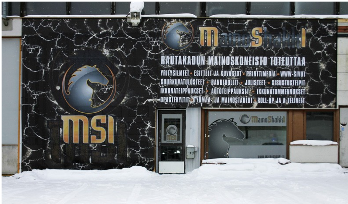
KUVIO 42. Räsistynyt julkisivu peitettiin jättitulosteella
