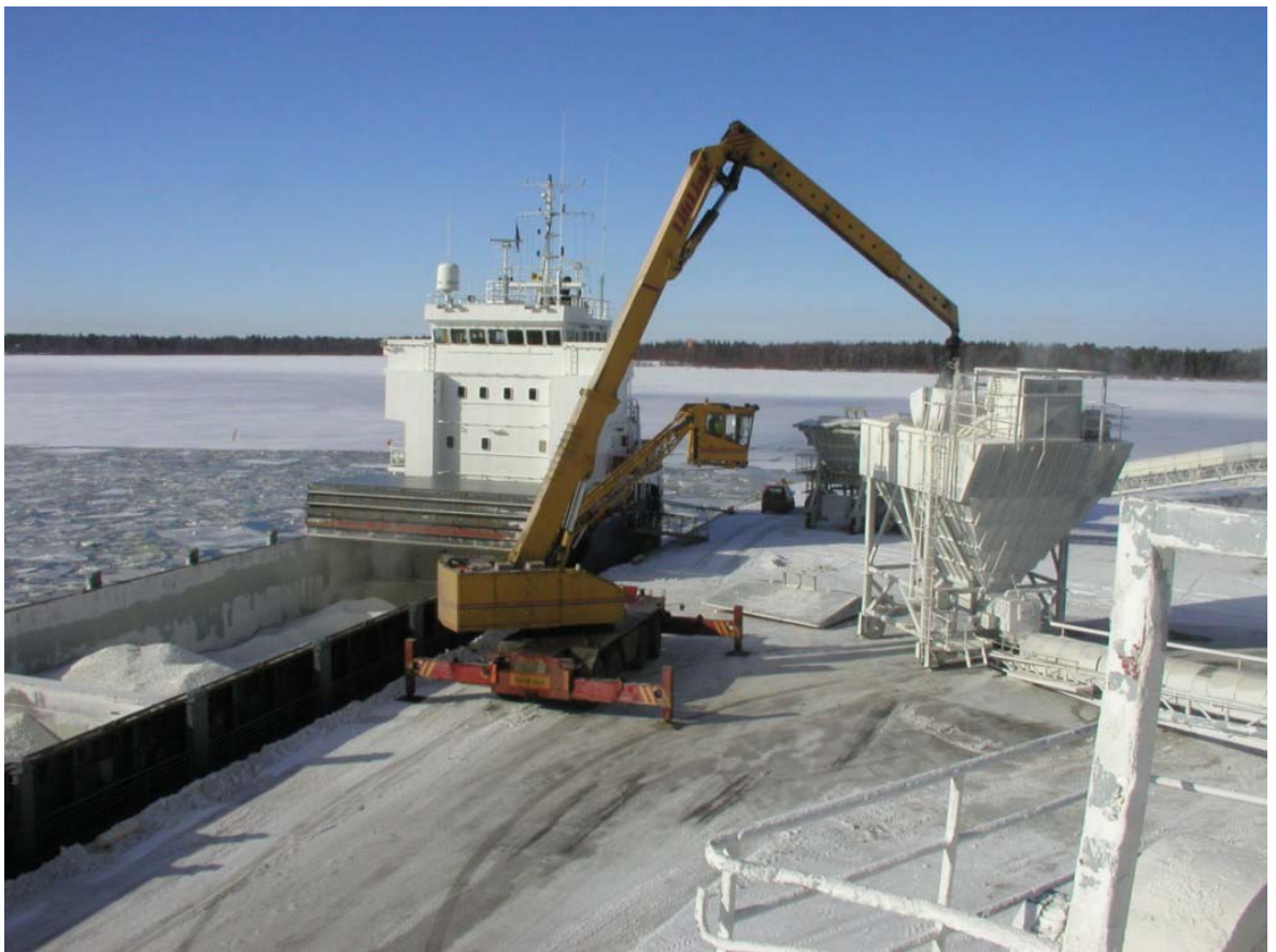
Kuva 2. Laivan purku vastaanottosuppiloihin /8/
