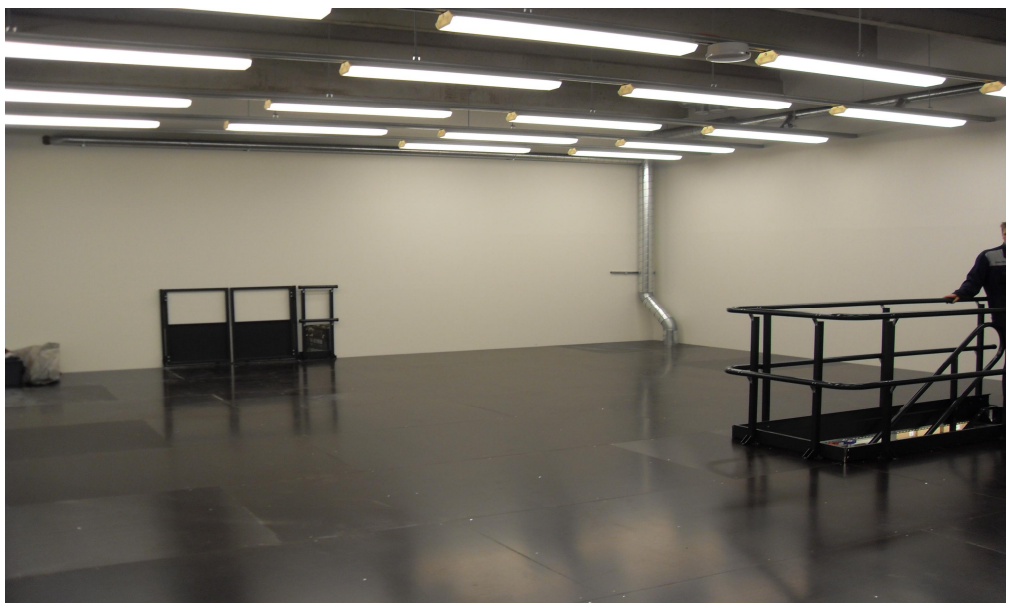
Kuva 9. Varaston 3. kerroksen tyhjätila
