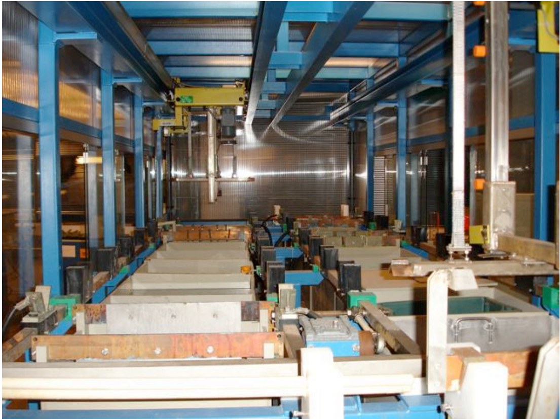
Kuva 11. Sähköpinnoituslinja, jossa kuljetin 1 näkyy takana ja kuljetin 2 oikealla.
