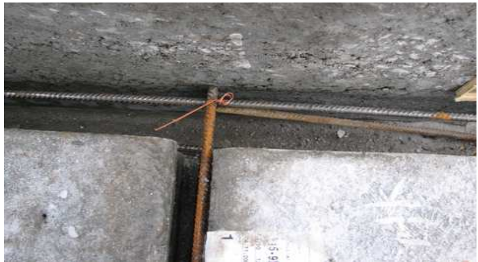
Kuva 26. Saumaraudat tulee ankkuroida rakenteen ulkokehälle. /3./
