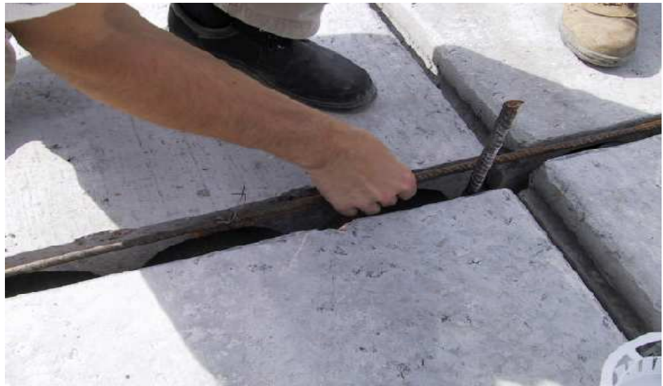
Kuva 22. Sisäpuoliset siteet voidaan ryhmittää tuen kohdalle. /17./
