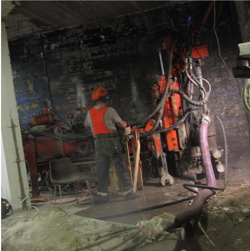
Kuva 5. Suihkuinjektoitavan kuilun porapaalutusta sähkökäyttöisellä Hütte 202 -poravaunulla.
