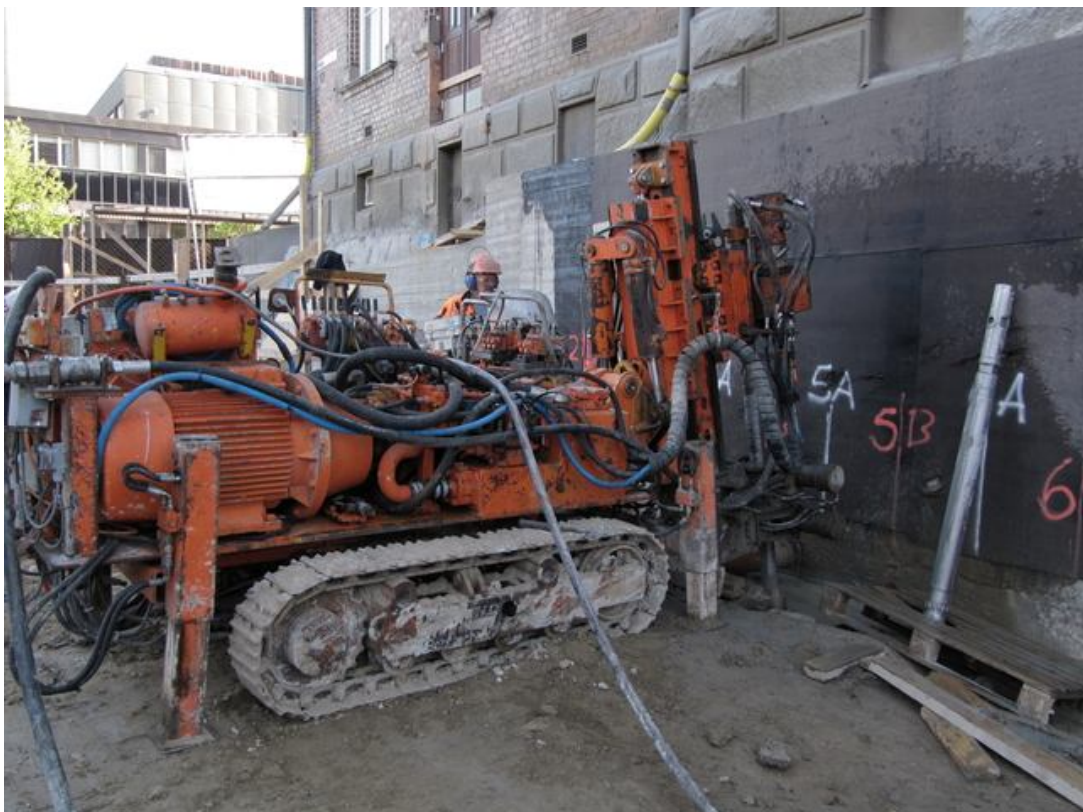
Kuva 2. Tampereen Pakkahuoneen perustusten suihkuinjektointia.
