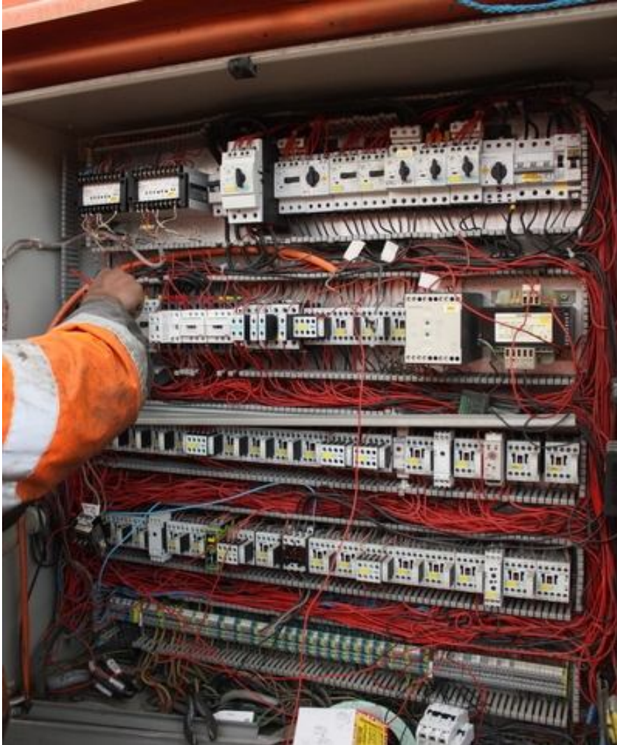
Kuva 9. Sekoitusaseman sähkökaapin tutkintaa.
