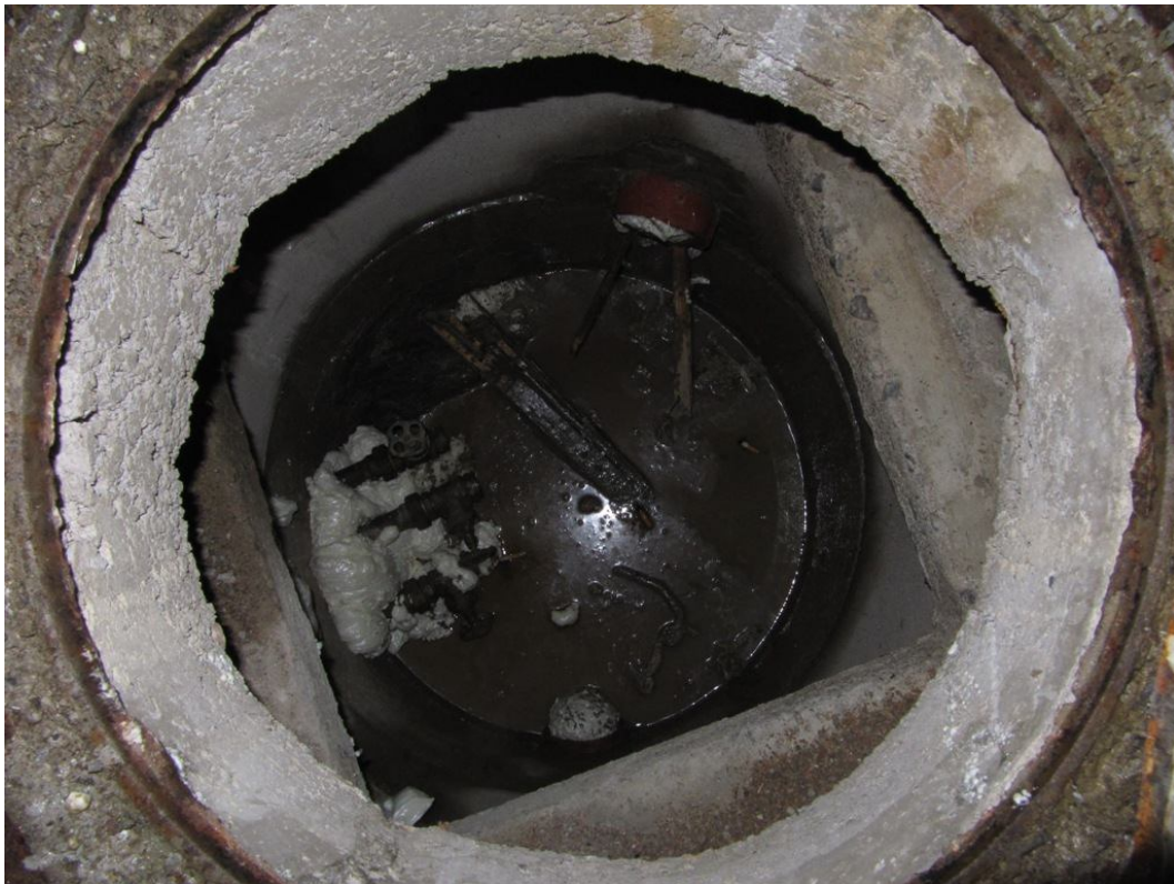
Kuva 4. Polyuretaanimassalla tukittuja salaojaputkia tarkastuskaivossa.
