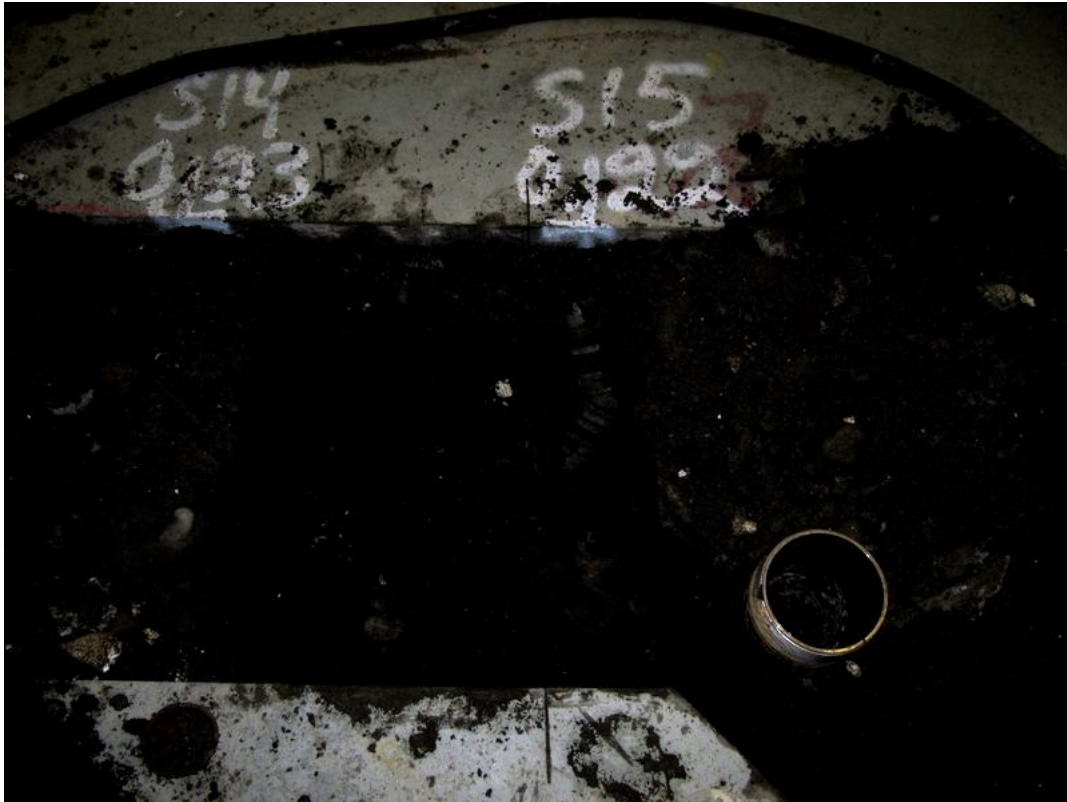
Kuva 6. Mittamiehen merkkäamat paalunpaikat.
