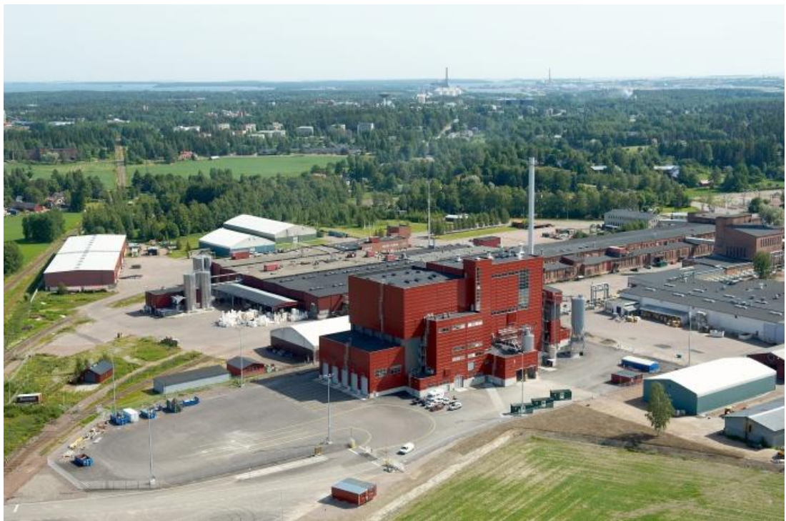
KUVA 2. Kotkan Energia Oy:n Hyötyvoimalaitos (Kotkan Energia Oy).
