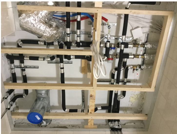
Kuva 4. Alakaton sisään jäävät talotekniikka-asennukset perinteisellä menetelmällä toteutussa linjasaneerauskohteessa. Vesijohtodot eristetty. [Kuva Janne Koivuholma]
