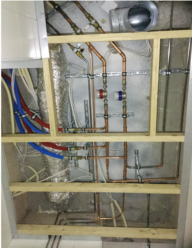
Kuva 3. Alakaton sisään jäävät talotekniikka-asennukset perinteisellä menetelmällä tehdyssä linjasaneerauskohteessa. Kuva otettu ennen vesijohtojen eristämistä. [Kuva Janne Koivuholma]
