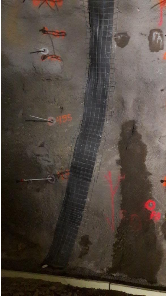
Kuva 8. Asennettu salaoja (Lindroos 2019).
