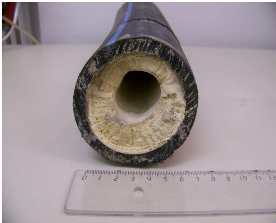
Kuva 16. Viemäriputken saostertymä (Harer 2017).
