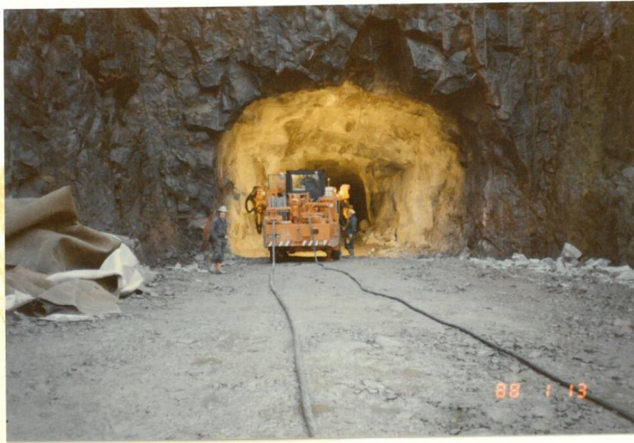
Kuva 6. Kuparivuoren tunnelin rakentaminen 1980-luvulla (Kuparivuoren maantietunneli 1988).
