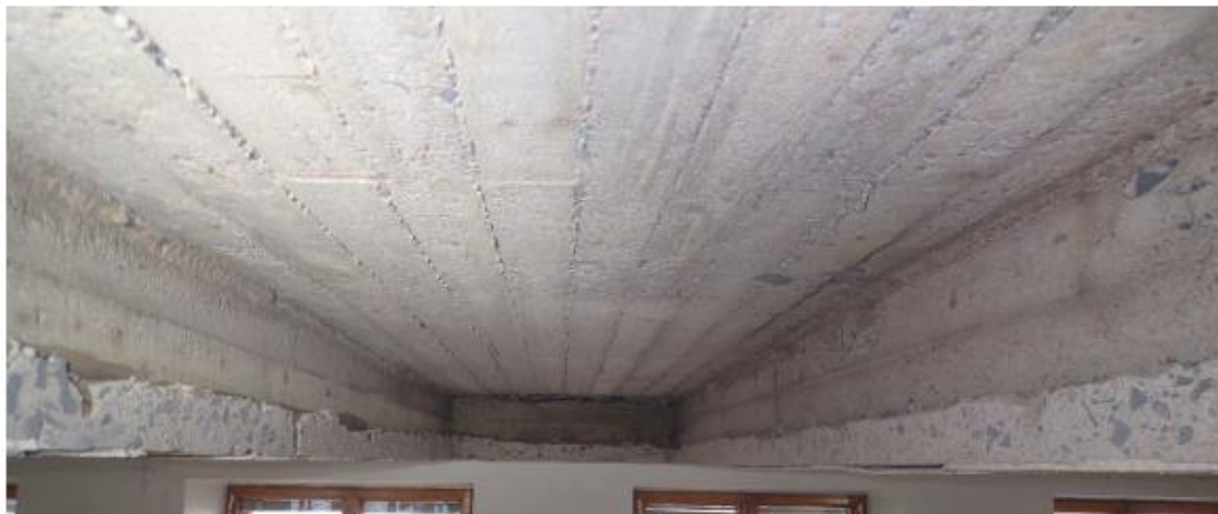
Kuva 11. Hyväksytysti puhdistettu välipohjaontelo.
