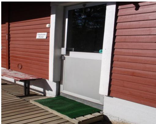
Kuva 16. Kulku miesten pukuhuoneeseen.
