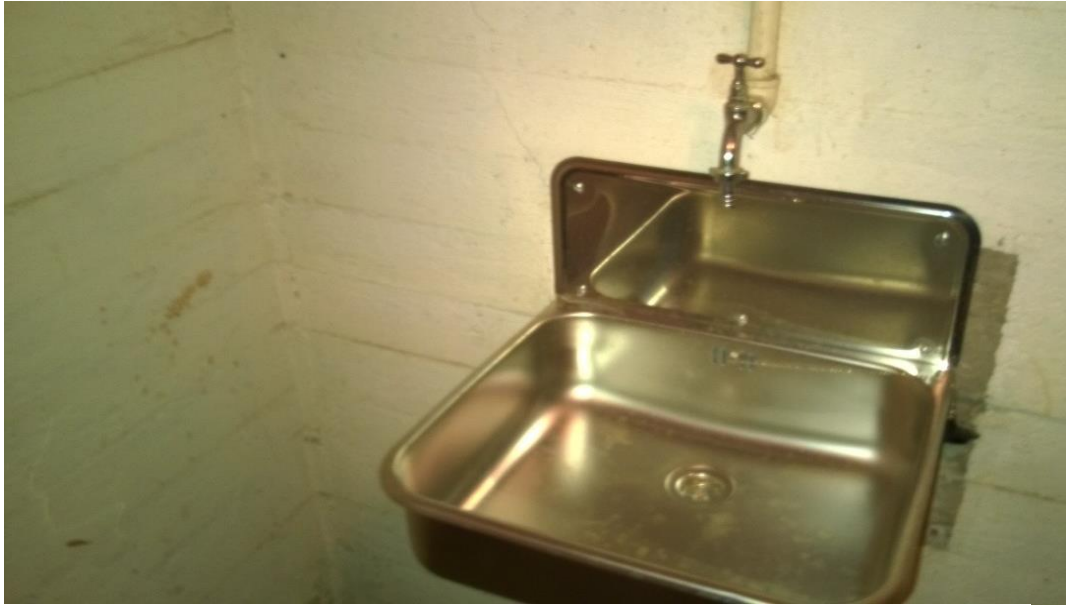
Kuva 6. Kellarissa on kaatoaltaat uusittu. Vesijohto ja sekoittaja ovat alkuperäiset.
