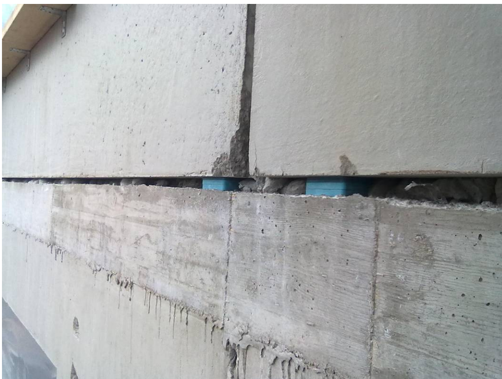
Kuva 5.2 Elementin alasauma tehty pumppauksella.
