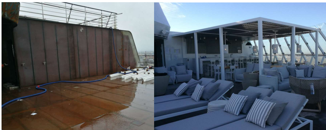
Kuva 1. Kuvapari telakan alihankkijalle toimittamasta teräsrunghosta ja valmiista alueesta kokonaistoimituksen jälkeen (Sance Oy 2018a).
