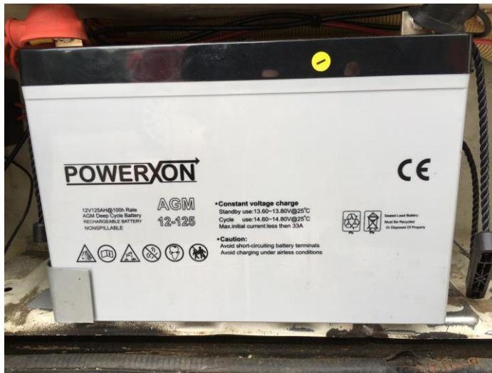
Kuva 9. Aurinkosähköjärjestelmän akku.
