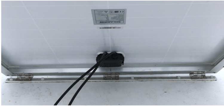
Kuva 7. Aurinkopaneeli kiinnitettyä kattoon saranoilla.
