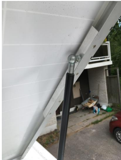
Kuva 8. Kaasujousen kiinnitys aurinkopaneeliin.
