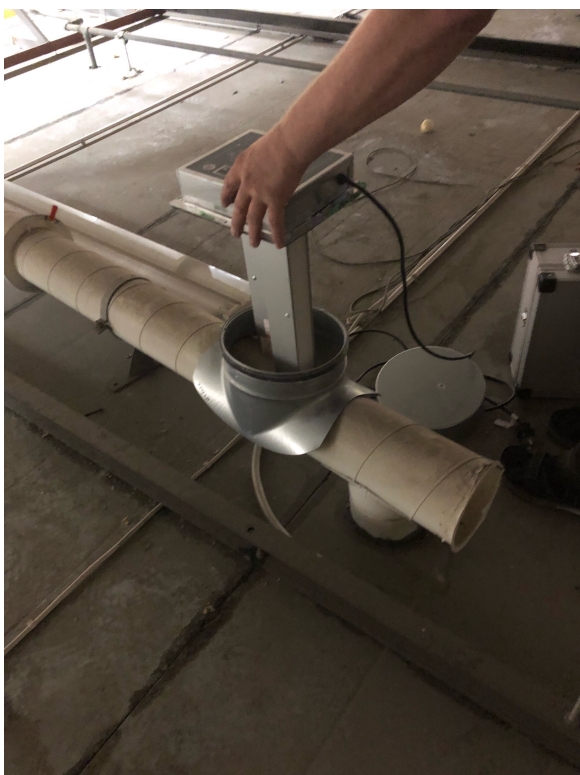
Kuva 10. ActivTek Induct 10000 -ilmanpuhdistimen asennus ilmanvaihtokanavaan.
